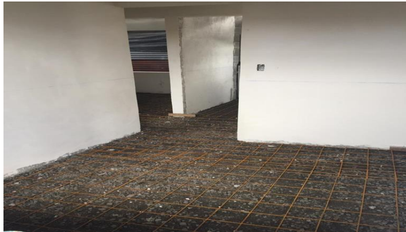
Armado de contrapiso.
