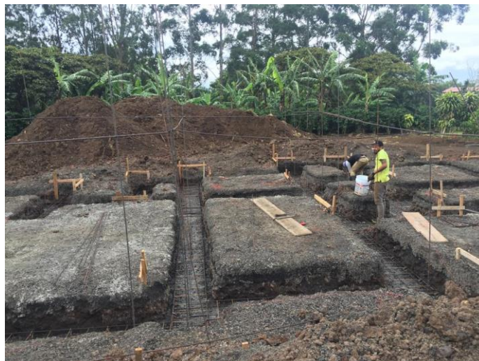
Zanjeo de Cimientos
