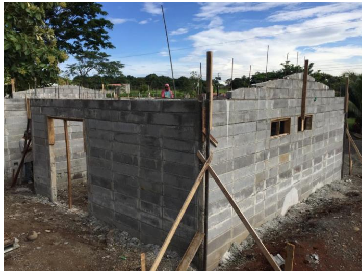
Pared de mampostería
