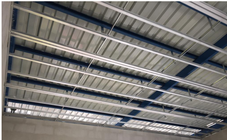
Cubierta de lámina ondulada.
