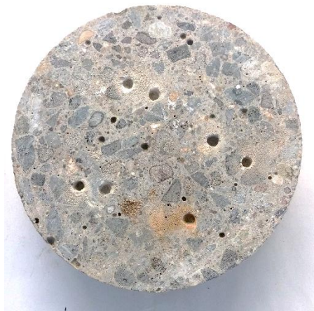
Figura 7.13 – Vista de la sección de concreto carbonatado y de la ubicación de las perforaciones para el análisis de caracterización del material.
