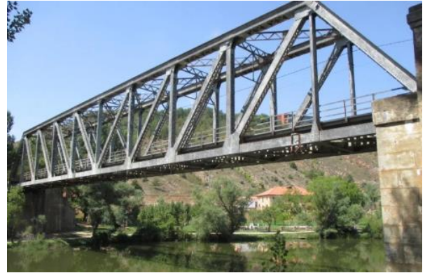
Figura 7. Puente de cercha paso inferior . Fuente: ALEU, en línea (2017).
