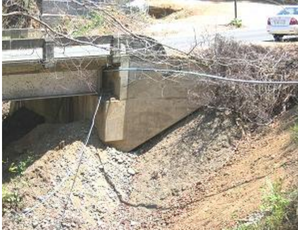
Figura 19. Relleno de aproximación. Fuente: MOPT (2007).
