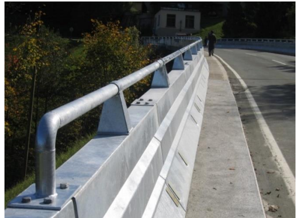
Figura 20. Baranda de un puente. Fuente: Revista Vial, en línea (2016).
