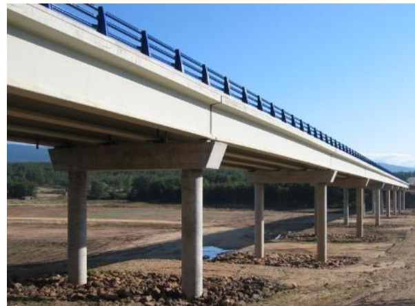
Figura 4. Puente de viga simple . Fuente: El diario Ranco, en línea (2016).
