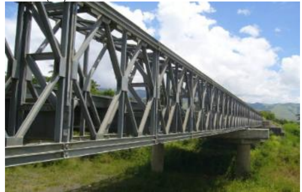
Figura 9. Puente de cercha de media altura, Bailey . Fuente: Alibaba, en línea (s.f).
