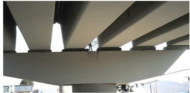
Figura 15. Placas de neopreno en un puente . Fuente: Industria Rubberparts, en línea (2016).
