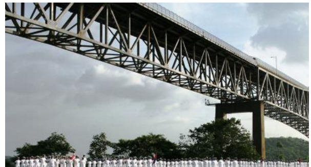
Figura 8. Puente de cercha paso superior . Fuente: MediaBros, en línea (s.f.).
