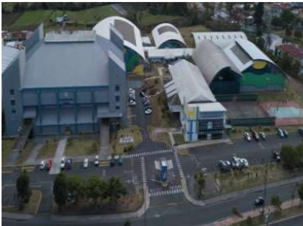
Figura 4. Estructura actual del Polideportivo de Cartago
