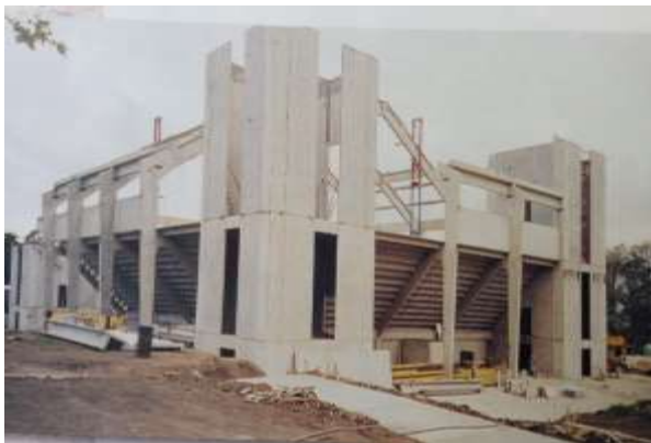
Figura 2. Estructura de 1998 del Polideportivo de Cartago.
