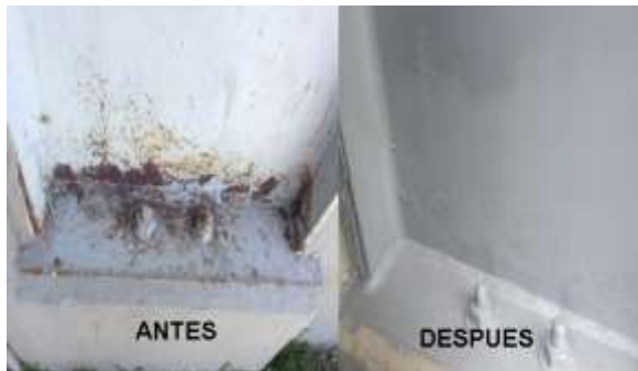
Figura 30. Antes y después de las columnas del Gimnasio Multiuso.
