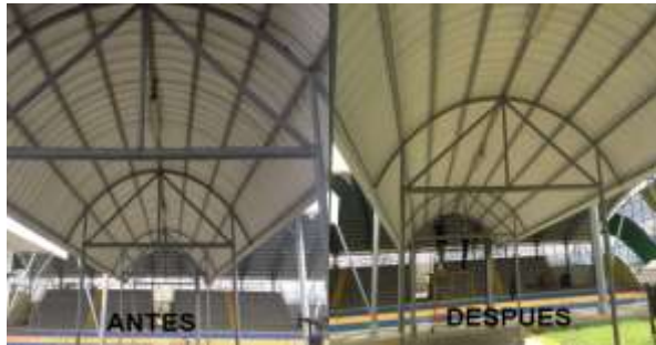
Figura 28. Antes y después de pasillo en piscinas.
