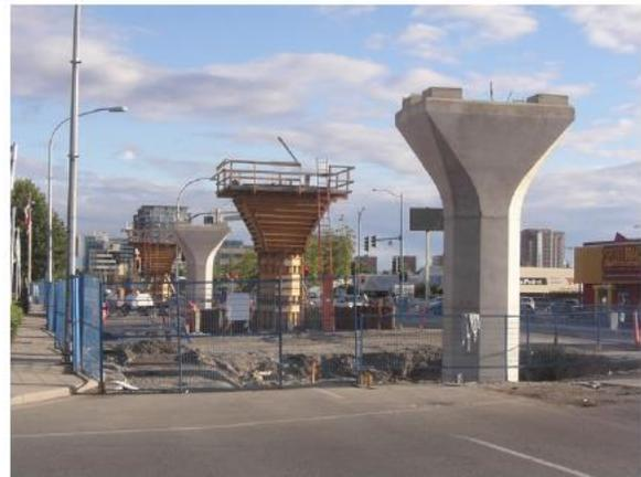
Figura 27. Columnas chorreadas en el sitio.
