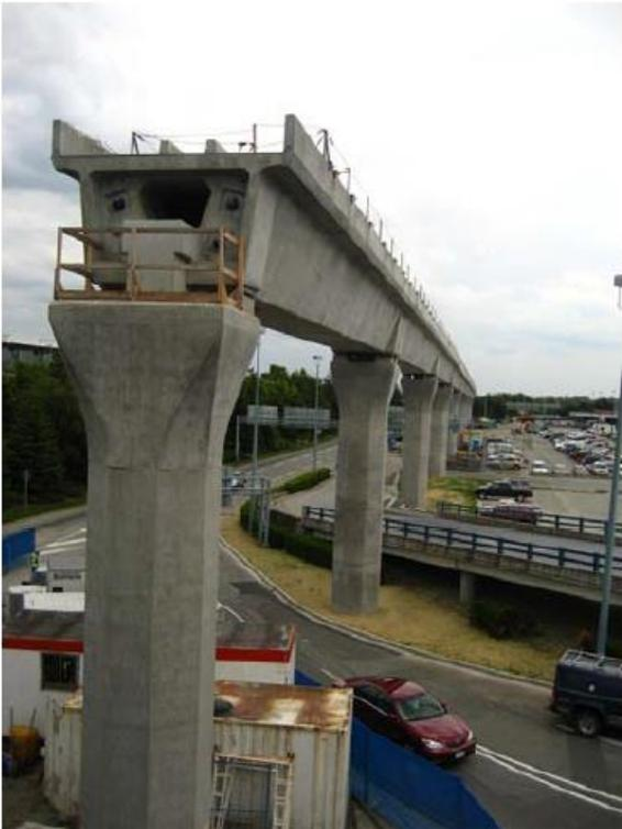
Figura 29. Una viga ferroviaria de vía única.
