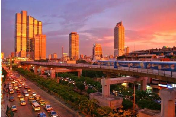
Figura 31. Estructura de concreto tipo marco, en lugar de una sola columna.
