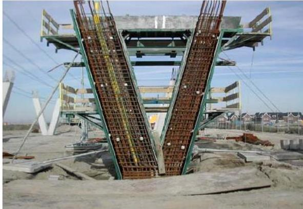
Figura 33. Refuerzo de las columnas en V.
