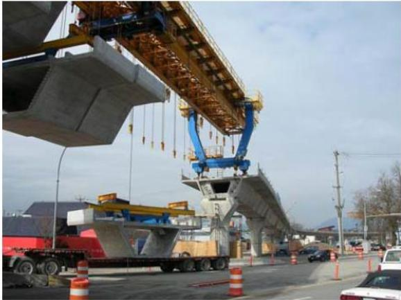
Figura 28. Construcción de las vigas tipo cajón utilizando las grúas de instalación lateral, tipo cerchas.
