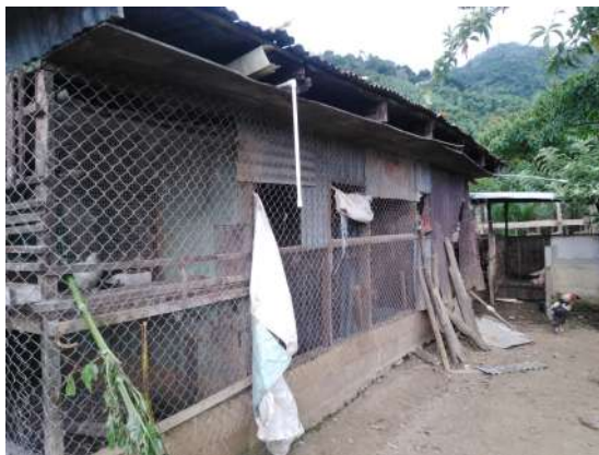
Anexo 21. Condiciones actuales de la estructura, Proyecto Granja Integral Fuente: Elaboración propia
