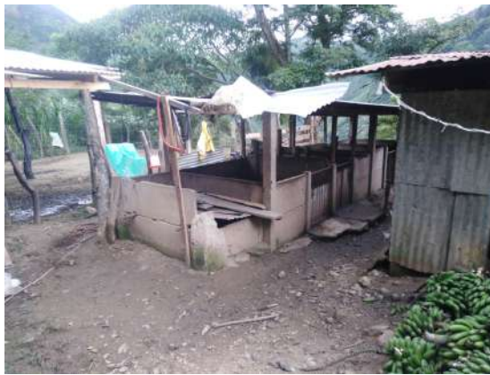
Anexo 20. Condiciones actuales de la estructura, Proyecto Granja Integral Fuente: Elaboración propia
