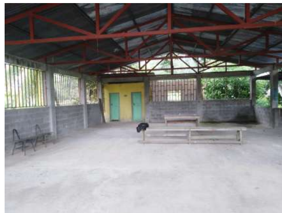
Anexo 11. Vista interior, Proyecto Salón Comunal Pocares Fuente: Elaboración propia
