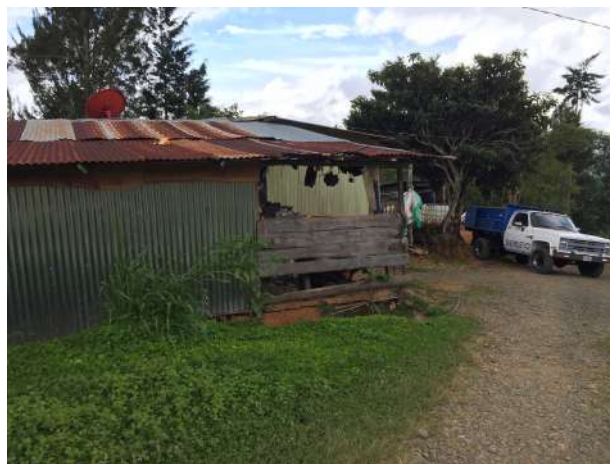
Anexo 17. Estructura existente, Bodega para almacenamiento de cultivos Fuente: Elaboración propia
