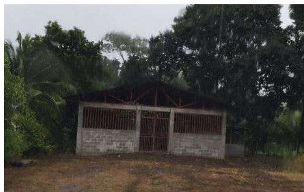
Anexo 12. Vista fachada frontal, Proyecto Salón Comunal Pocares Fuente: Elaboración propia
