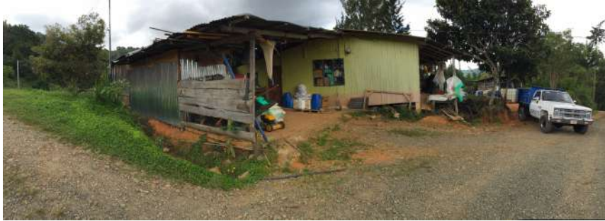
Anexo 16. Estructura existente, Proyecto Bodega para almacenamiento del cultivos Fuente: Elaboración propia
