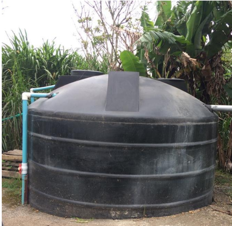
Figura 7. Tanque de plástico de San Francisco de Birrisito con volumen de 22000 L.
