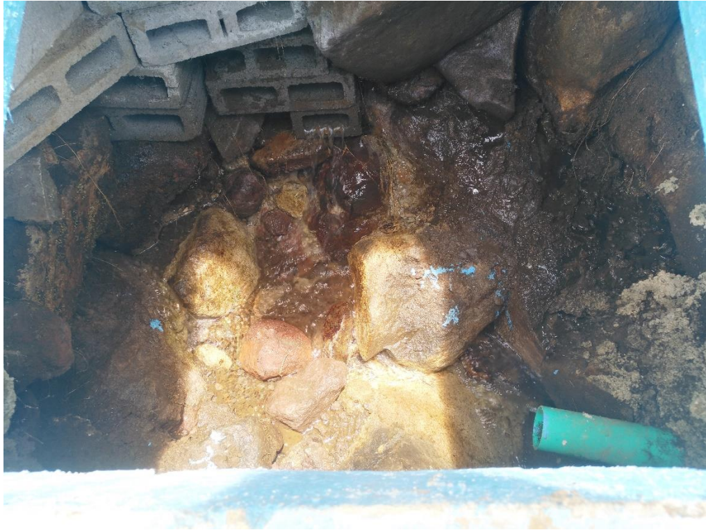
Figura 11. Obra de toma naciente de tipo manantial
