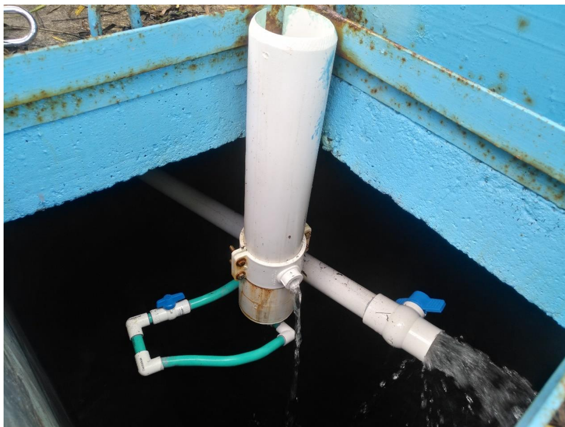
Figura 14. Sistema de desinfección por cloración
