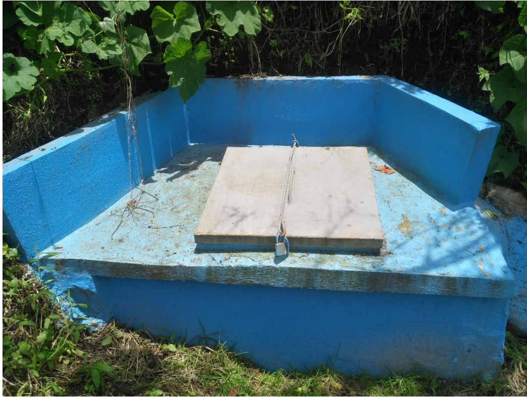
Figura 12. Obra de protección para una naciente tipo manantial
