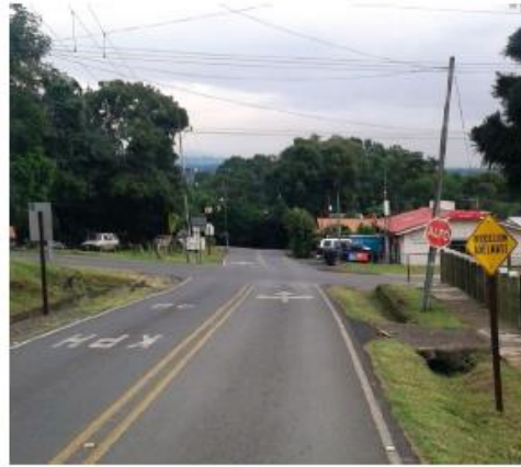
Intersección Concepción sentido suroeste – noreste
