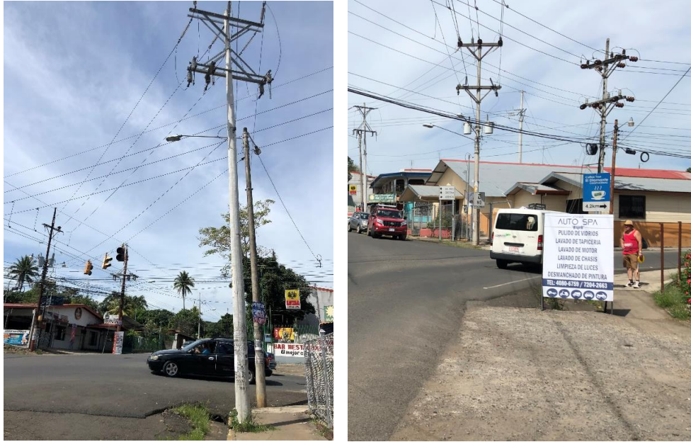
Figura N° 4-30 – Postes cercanos a la vía.
