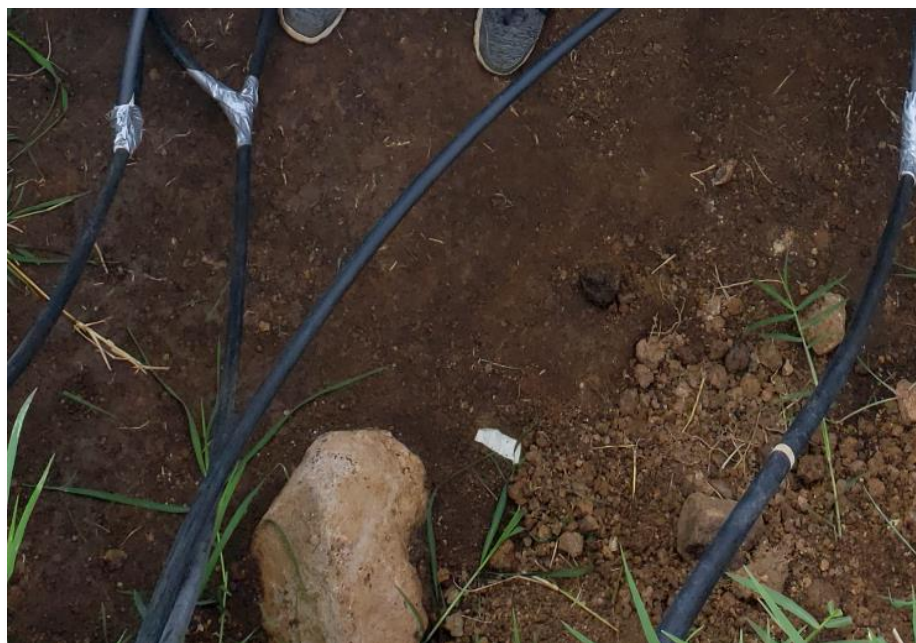
Figura 4.16. Tuberías y líneas protegidas por el poliducto
