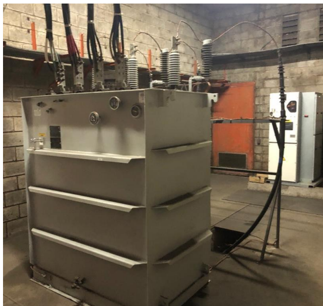
Apéndice 1. Celda de media tensión DVCAS de Schneider Electric.
