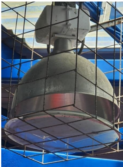
Figura 42. Luces HID del gimnasio de la escuela Domingo Faustino Fuente: Tomada por el investigador
