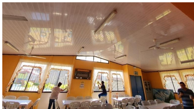
Figura 9. Iluminación del comedor de la escuela La Pitahaya
