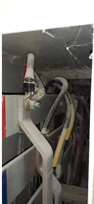
Figura 41. Barras de distribución hacia cargas de la planta. Fuente: Elaboración propia.
