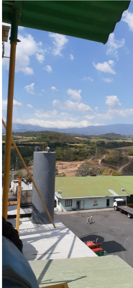
Figura 31. Tanque almacenamiento aceite vegetal Fuente: Elaboración propia.
