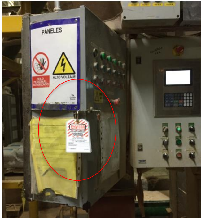
Figura 11. Colocación del bloqueo y etiquetado en cajas de control
