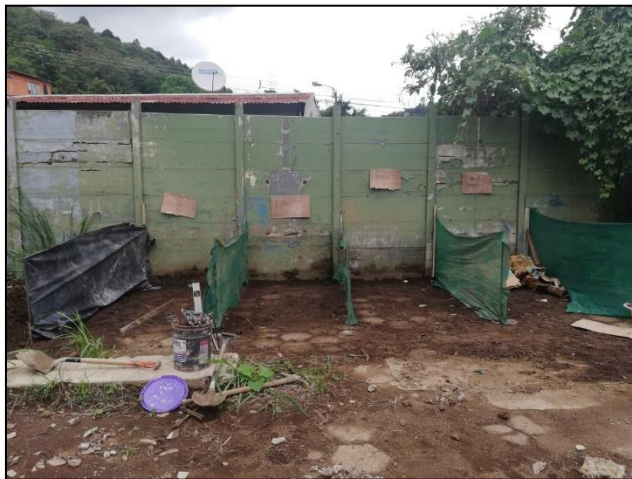
Figura 91. Nueva área de centro de acopio adecuado establecido. Fuente: Elaboración propia en visita a proyecto en Parque La Libertad
