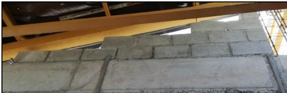
Figura 45 Uso de bloques de mampostería en tapichel en proyecto. Fuente: Elaboración propia en visita a proyecto en Siquirres.
