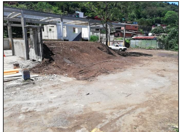
Figura 89. Área de centro de acopio interrumpida por actividades de demolición y relleno. Fuente: Elaboración propia en visita a proyecto en Parque La Libertad.
