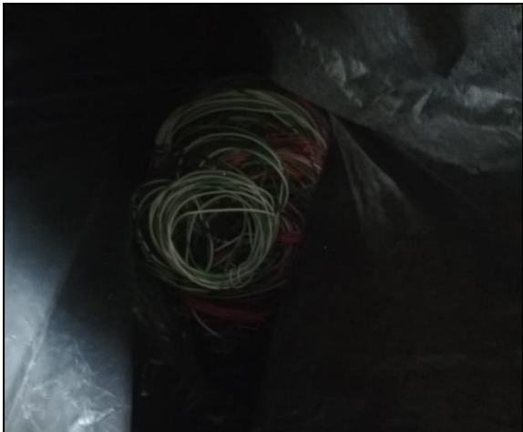
Figura 37. Almacenamiento de cableado eléctrico en obra. Fuente: Elaboración propia en visita a proyecto en Siquirres.
