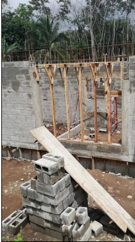
Figura 49. Uso de formaleta en proyecto. Fuente: Elaboración propia en visita a proyecto en Siquirres.
