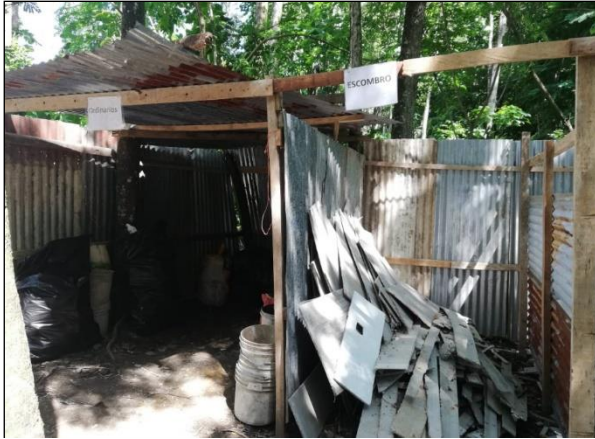
Figura 31. Centro de acopio mejorado para los residuos de basura ordinaria y escombros. Fuente: Elaboración propia en visita a proyecto en Siquirres.
