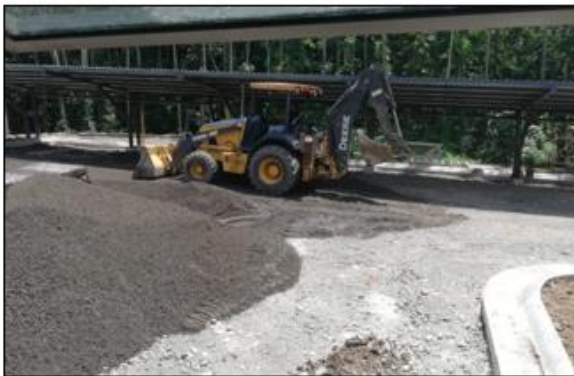
Figura 32. Control de polvo en relleno
