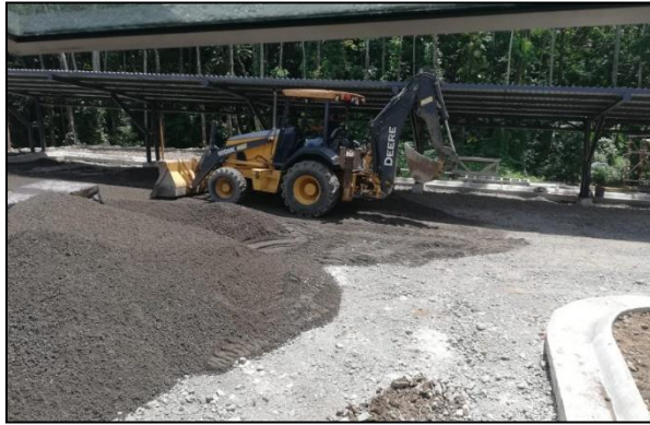
Figura 78. Actividades de compactación tomando medidas de control de polvo. Fuente: Elaboración propia en visita a proyecto en Siquirres.
