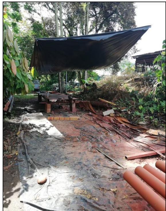
Figura 61. Protección de suelo en actividades con pintura. Fuente: Elaboración propia en visita a proyecto en Siquirres.
