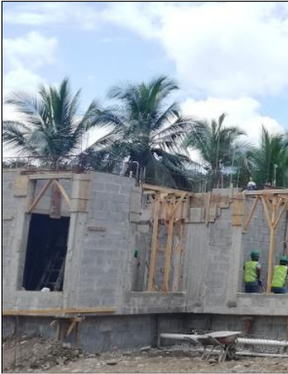
Figura 53. Geometría del edificio que provocó incremento en uso de formaleta. Fuente: Elaboración propia en visita a proyecto en Siquirres.
