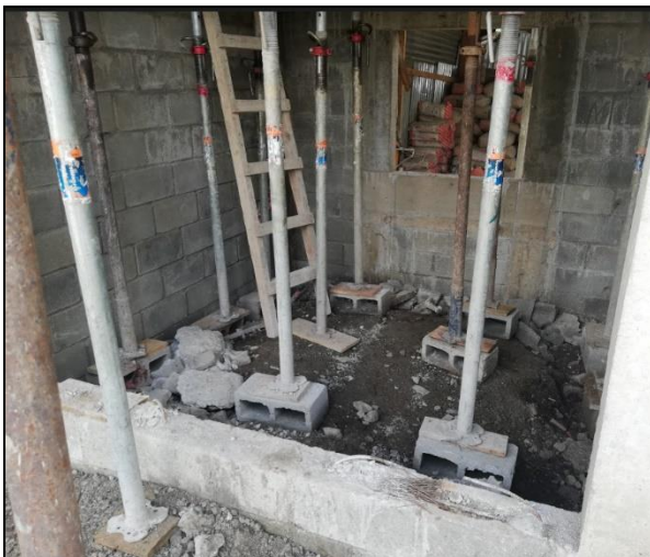
Figura 76. Piso de bodega a ser relleno con materiales de tipo cementicios y áridos. Fuente: Elaboración propia en visita a proyecto en Siquirres.
