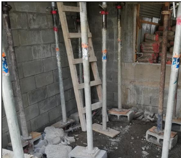
Figura 59. Sistemas de apuntalamiento utilizados en obra. Fuente: Elaboración propia en visita a proyecto en Siquirres.
