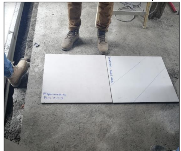
Figura 65. Evaluaci3n de la colocaci3n 3ptima de las piezas de porcelanato en proyecto. Fuente: Elaboraci3n propia en visita a proyecto en Siquirres.
