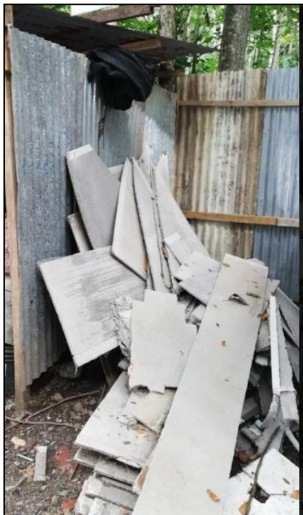
Figura 121. Centro de acopio de residuos de durock en la última fecha de control. Elaboración propia en visita a proyecto en Siquirres
