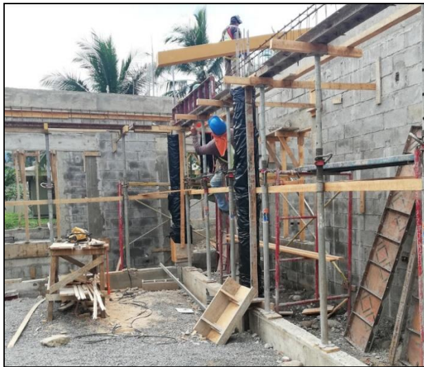
Figura 50. Uso de formaleta en proyecto. Fuente: Elaboración propia en visita a proyecto en Siquirres.
