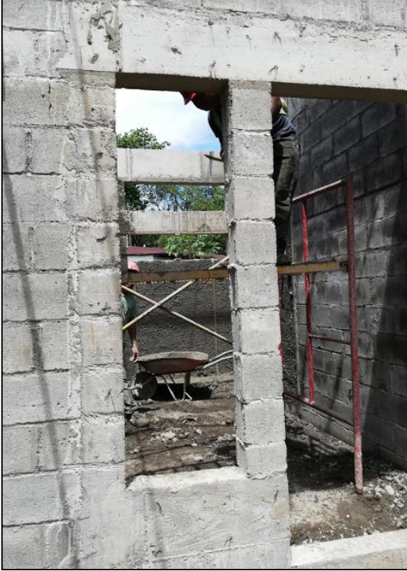
Figura 44. Tipo de columnetas del diseño. Fuente: Elaboración propia en visita a proyecto en Siquirres.
