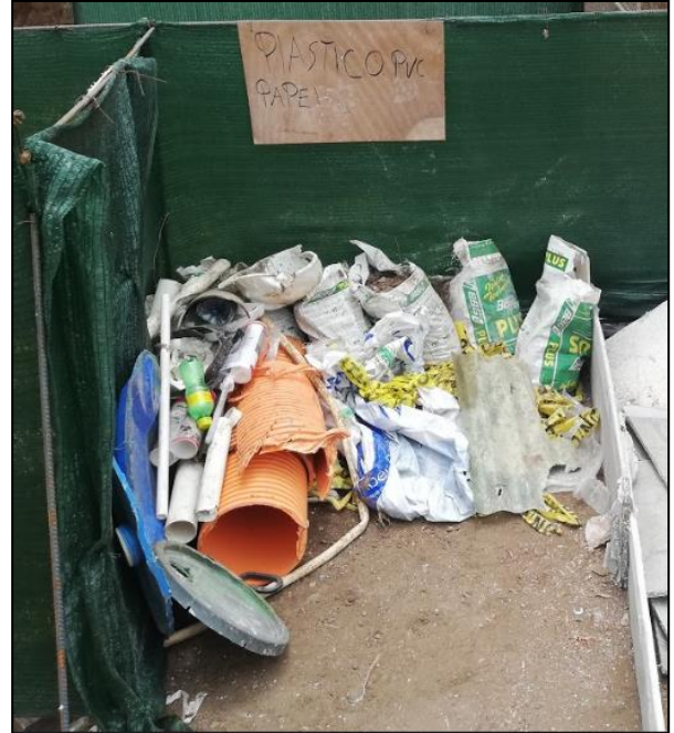
Figura 88. Incorrecta separación de residuos en proyecto Fuente: Elaboración propia en visita a proyecto en Parque La Libertad.
