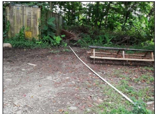
Figura 81. Disposición de aguas provenientes del comedor del proyecto. Fuente: Elaboración propia en visita a proyecto en Siquirres
