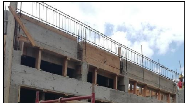
Figura 48. Uso de formaleta en proyecto. Fuente: Elaboración propia en visita a proyecto.
