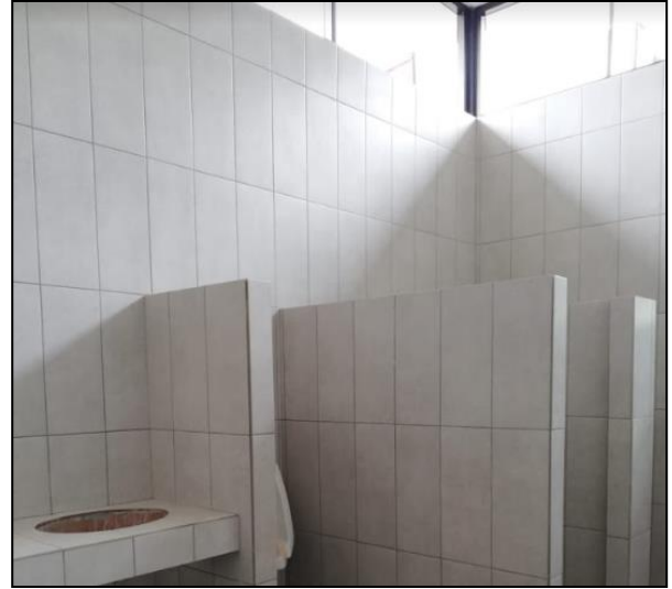
Figura 72. Colocación final de cerámica en paredes de baños. Fuente: Elaboración propia en visita a proyecto en Siquirres.
