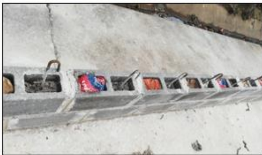
Figura 45. Reutilización de sacos de cemento en obra
