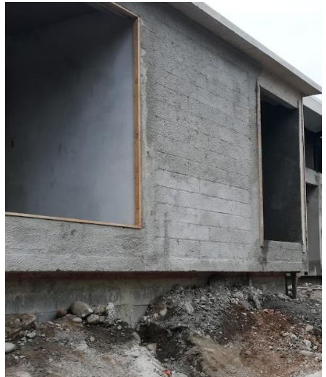
Figura 55. Geometría del edificio que provocó incremento en uso de formaleta. Fuente: Elaboración propia en visita a proyecto en Siquirres.
