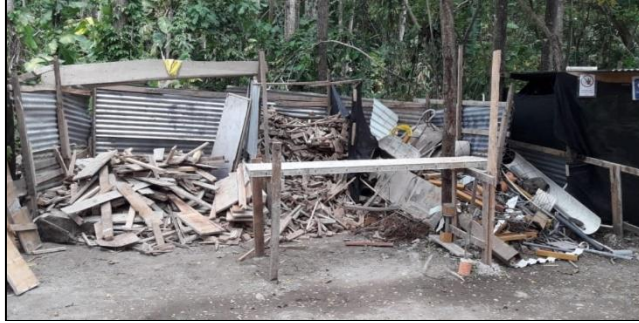
Figura 23. Centro de acopio de madera, acero y plástico PVC en proyecto. Fuente: Elaboración propia en visita a proyecto en Siquirres.
