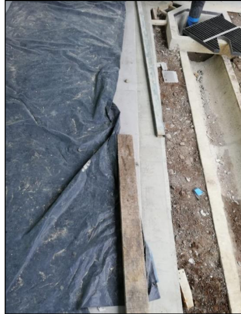
Figura 68. Franja de concreto lavado para sección de pisos en zona verde interna.
