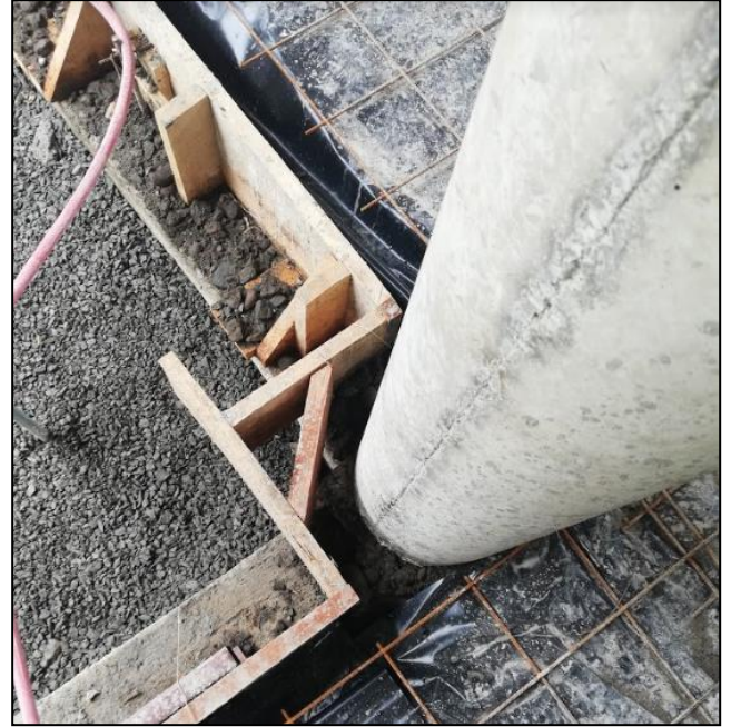
Figura 47. Uso de formaleta en proyecto. Fuente: Elaboración propia en visita a proyecto en Siquirres.
