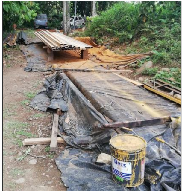
Figura 60. Protección de suelo en actividades con pintura. Fuente: Elaboración propia en visita a proyecto en Siquirres.
