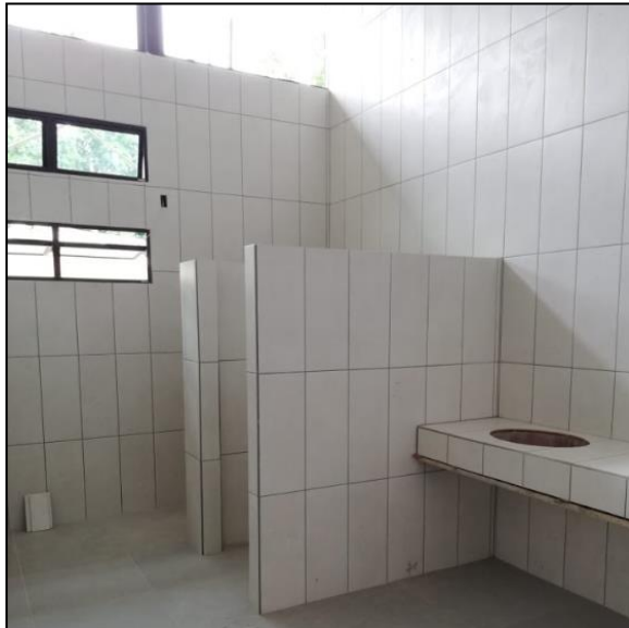
Figura 71. Resultado de la colocación de cerámica en paredes de baños.
