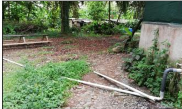
Figura 34. Mal tratamiento de aguas de la cocina del campamento del proyecto
