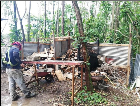
Figura 19. Centro de acopio de madera, acero y plástico PVC.
