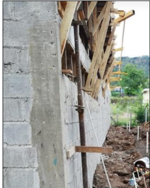
Figura 51. Uso de formaleta en proyecto. Fuente: Elaboración propia en visita a proyecto en Siquirres.
