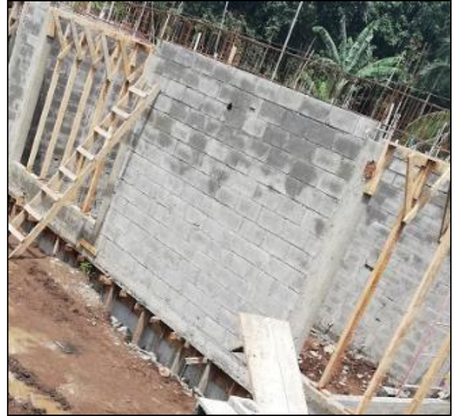
Figura 54. Uso de formaleta en viga perimetral. Fuente: Elaboración propia en visita a proyecto en Siquirres.
