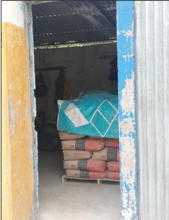
Figura 87. Uso de estructuras existentes en el proyecto para el almacenamiento de sacos de cemento. Fuente: Elaboración propia en visita a proyecto en Parque La Libertad.
