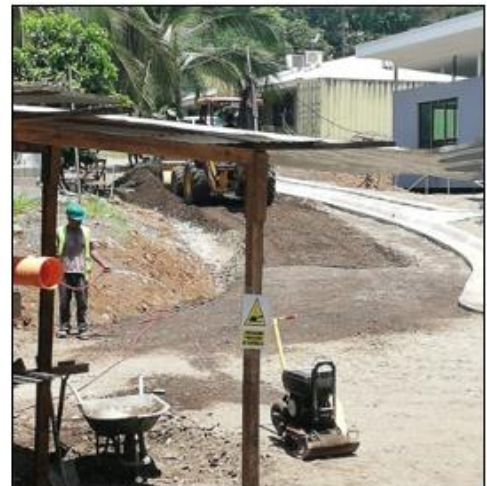
Figura 33. Control de polvo en compactación
