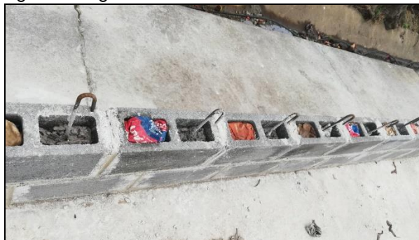
Figura 102. Reutilización bolsas de cemento en muro de mampostería.
