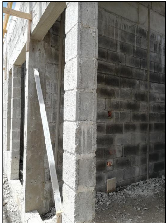
Figura 43. Tipo de columnetas del diseño. Fuente: Elaboración propia en visita a proyecto en Siquirres.
