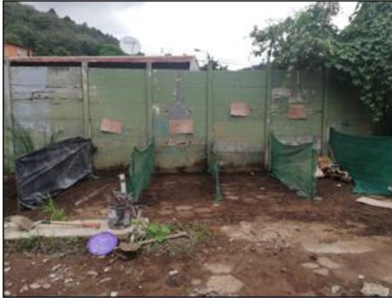
Figura 43. Proceso de corrección de centro de acopio
