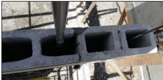
Figura 26. Colocación de blocks que genera residuos
