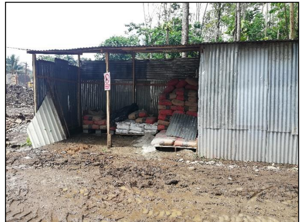
Figura 21. Centro de acopio de sacos de cemento
