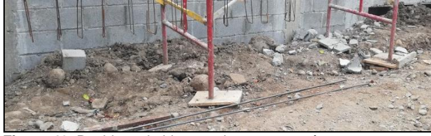
Figura 40. Residuos de bloques de mampostería en proyecto. Fuente: Elaboración propia en visita a proyecto en Siquirres.
