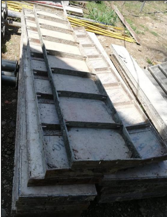
Figura 58. Sistema de formaleta empleado en obra. Fuente: Elaboración propia en visita a proyecto en Siquirres.
