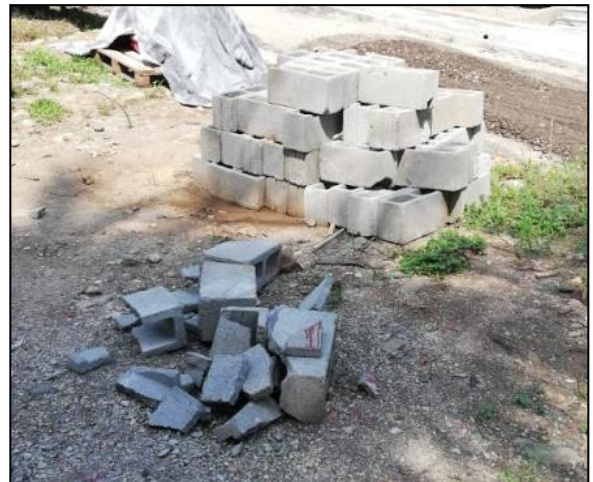
Figura 38. Residuos de bloques de mampostería en proyecto. Fuente: Elaboración propia en visita a proyecto en Siquirres.
