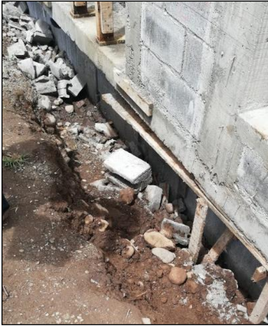
Figura 41. Residuos de bloques de mampostería en proyecto. Fuente: Elaboración propia en visita a proyecto en Siquirres
