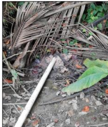
Figura 36. Mala disposición de aguas de la cocina del campamento
