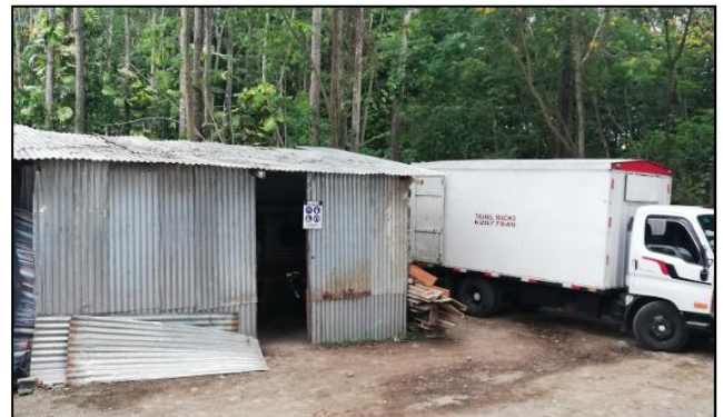
Figura 22. Acceso al centro de acopio para camiones.
