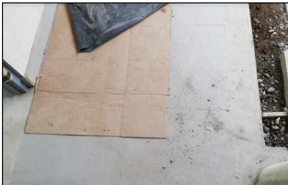
Figura 67. Colocación de piso con franja de concreto lavado para reducir desperdicio de porcelanato.
