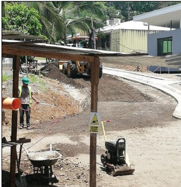
Figura 79. Riego de superficie en actividades de compactación. Fuente: Elaboración propia en visita a proyecto en Siquirres.
