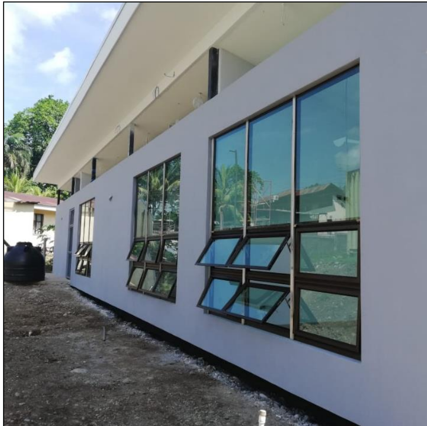
Figura 57. Concepto de edificio "flotando" a lo largo del perímetro. Fuente: Elaboración propia en visita a proyecto en Siquirres.
