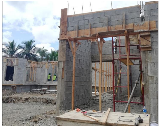
Figura 52. Uso de formaleta en proyecto. Fuente: Elaboración propia en visita a proyecto en Siquirres.
