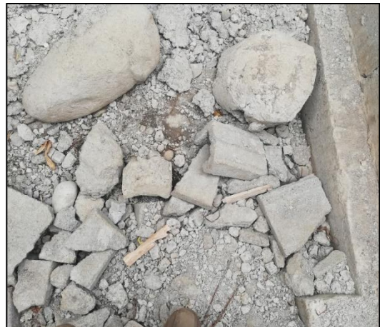
Figura 39. Residuos de blocks de mampostería en proyecto. Fuente: Elaboración propia en visita a proyecto en Siquirres.
