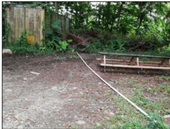
Figura 35. Mala disposición de aguas de la cocina del campamento
