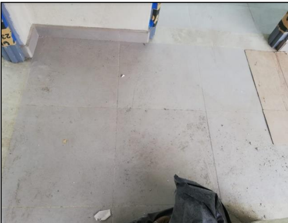
Figura 66. Colocación final piso en pasillo de zona verde interna.
