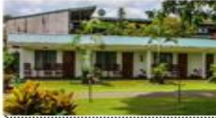
VISTA MÓDULO A
