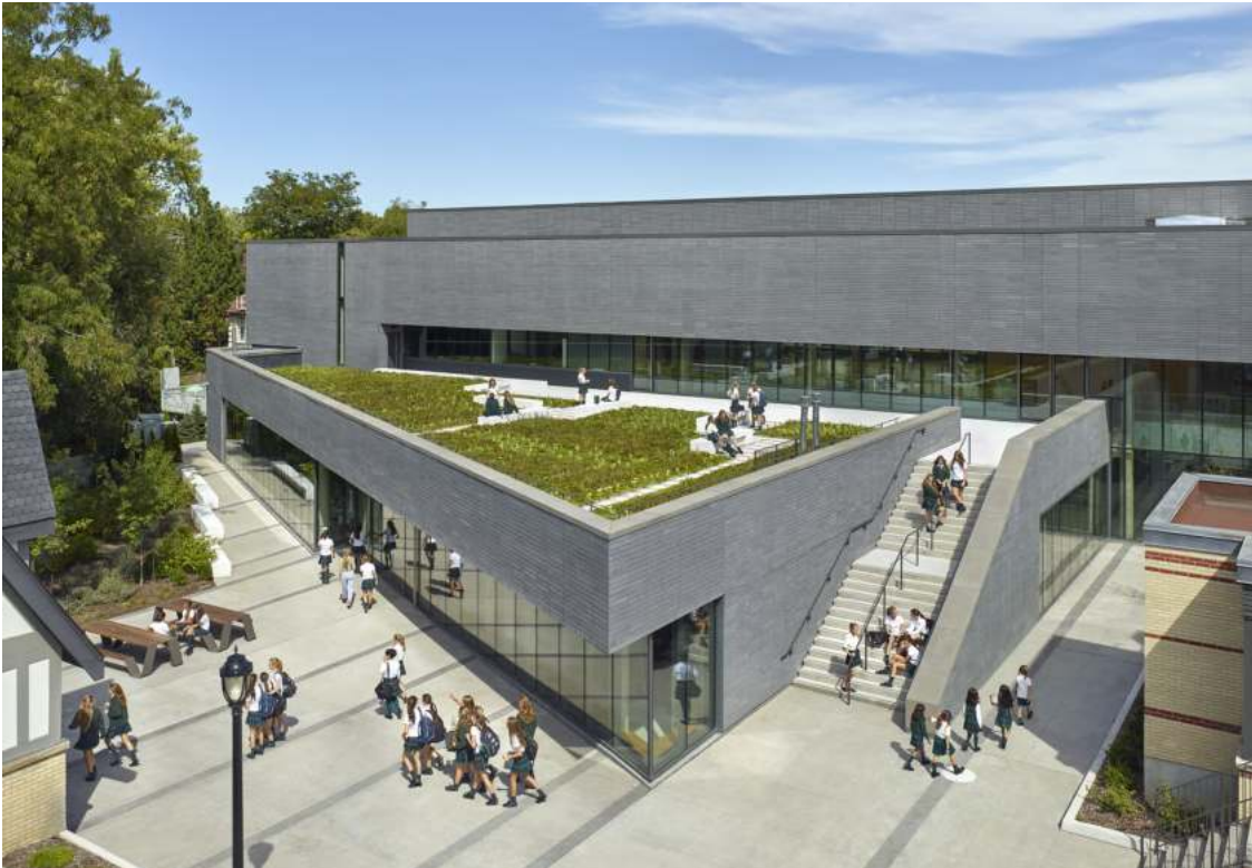
Imagen nº41: Vista externa y del techo verde del Hall Atlético Branksome
