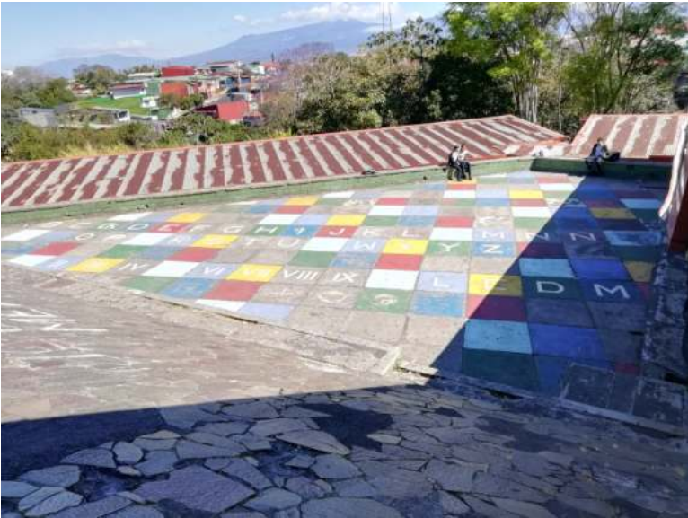
Imagen n°71 Vista del estado actual del planché
