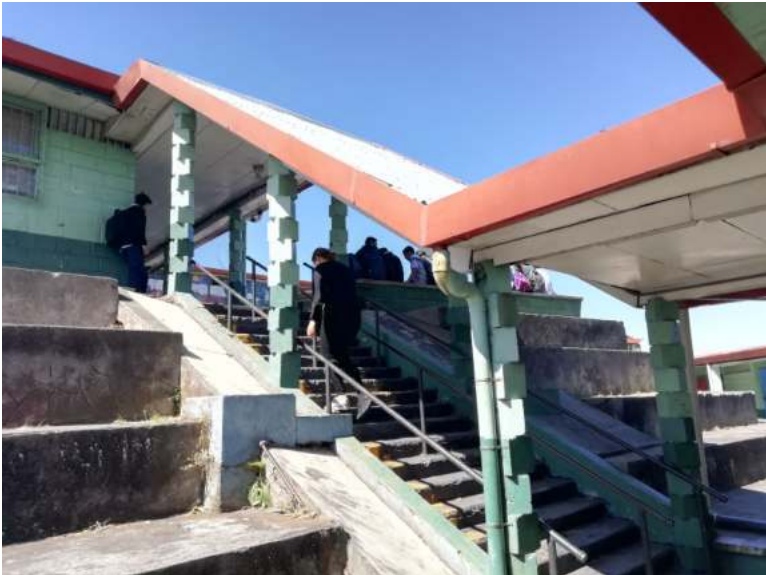
Imagen n°83: Gradas de acceso a los pabellones de aulas
