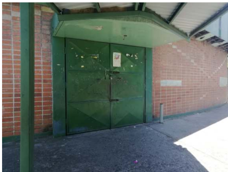
Imagen n°82: Vista exterior del gimnasio
