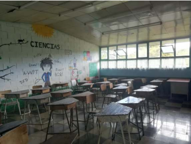
Imagen n°66: Vista interior de las aulas
