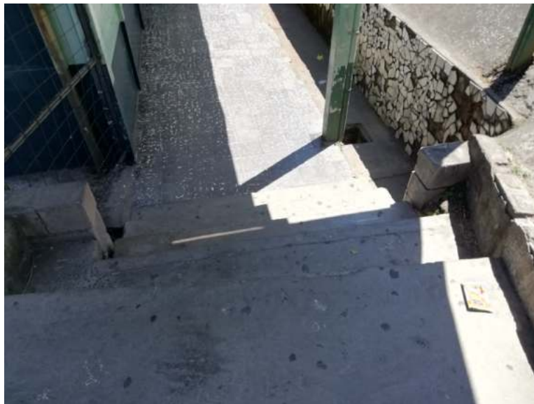
Imagen n°86: Gradas de acceso a la misma rampa
