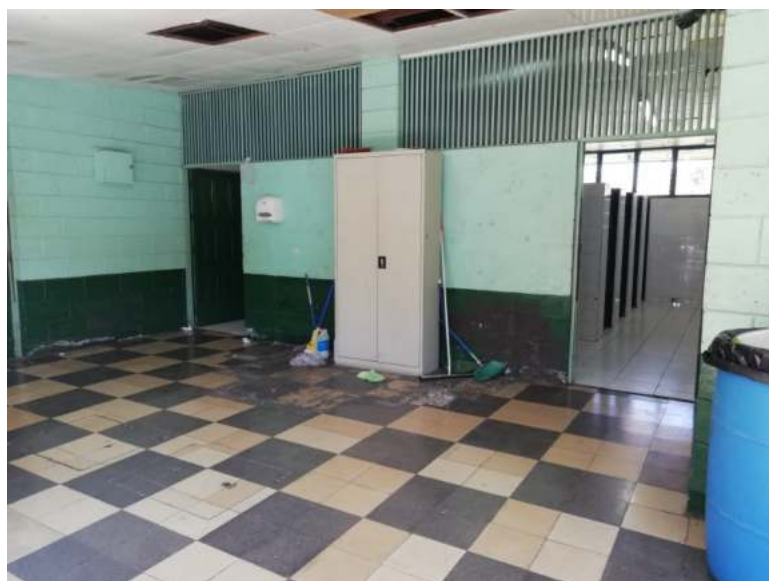
Imagen n°81: Vista exterior de los servicios sanitarios
