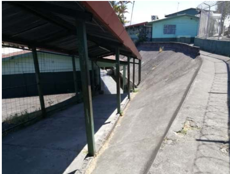
Imagen n°85: Rampa de acceso a un pabellón de aulas
