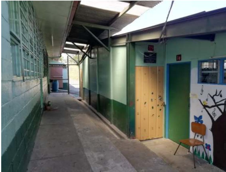
Imagen n°64: Vista exterior de las aulas de educación especial
