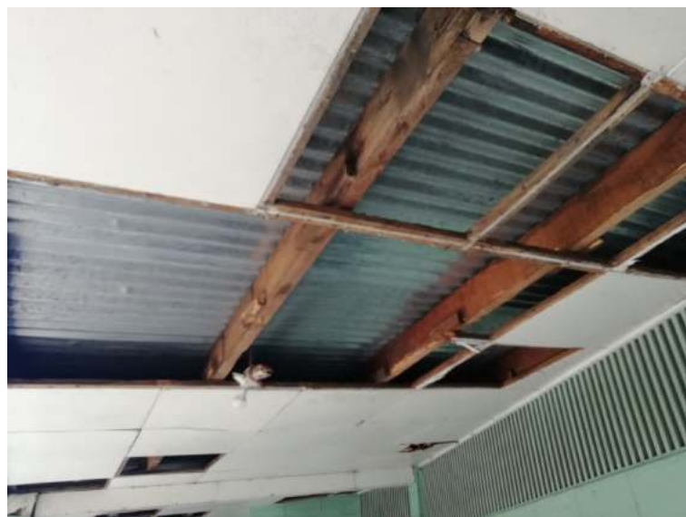
Imágenes n°69 y n°70: Daños en la estructura de techos y en puertas
