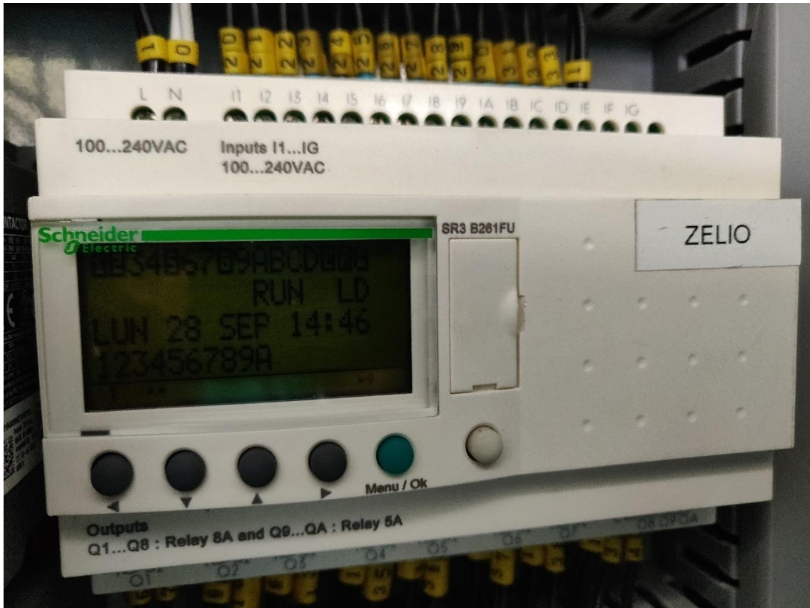
Figura 10.6 Relé inteligente para el control de las bombas.
