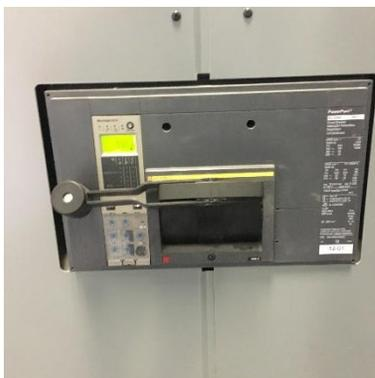
**Imagen 19. Desconectador principal de la subestación.**
