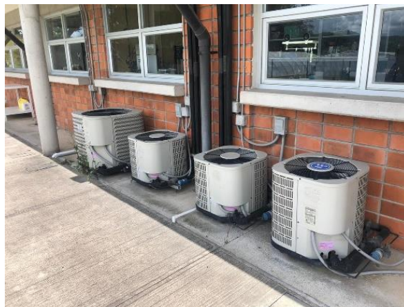
Figura 12. Unidades condensadoras de cuartos en el Laboratorio de Biotecnología
