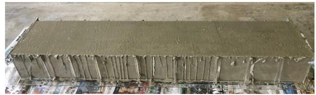
Figura 29 Colado de vigas a escala reducida
