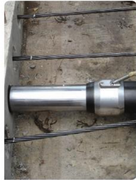
Figura 10. Anclaje en losa postensada Fuente: CCL, 2016
