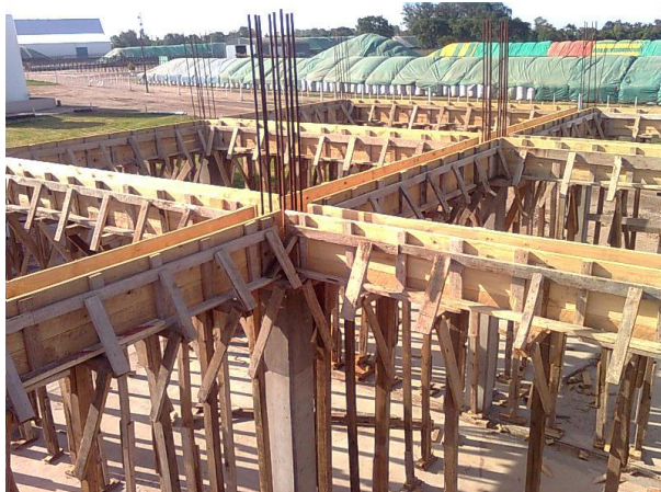
Figura 2. Encofrado de madera para el colado de vigas. Fuente: Civilexcel
