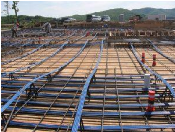
Figura 9. Conductos con los tendones sin presforzar Fuente: Mundo Avenida, 2017
