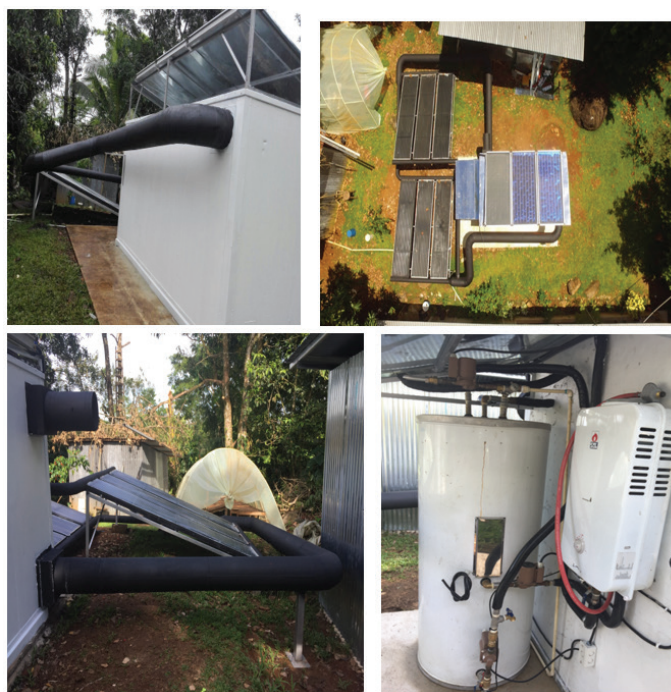
Figura 15. Sistema térmico solar activo híbrido con agua y aire caliente con sistema auxiliar de gas LP, implementado en ASOPAC-SIBAELI para el secado de cacao.
