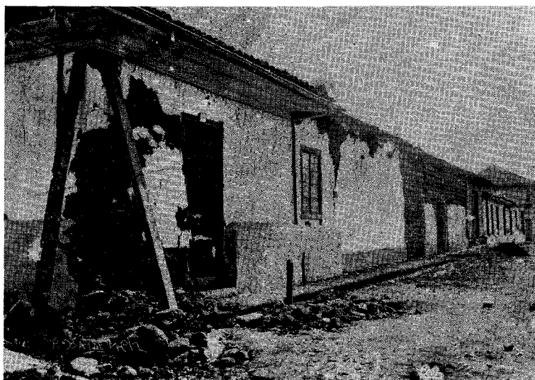
Daños causados á las casas de San José por el terremoto del 30 de diciembre de 1888, á las 4 y 12 m. de la mañana
