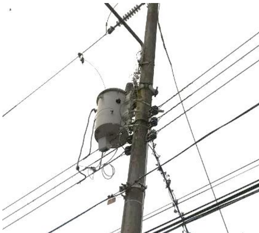
Figura 10.2.23 Montaje de equipo medidor en transformador en circuito Cto.Río Macho-Poste 70.
