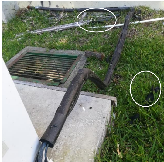
Figura 6-11 Aislamiento reemplazado en la intemperie
