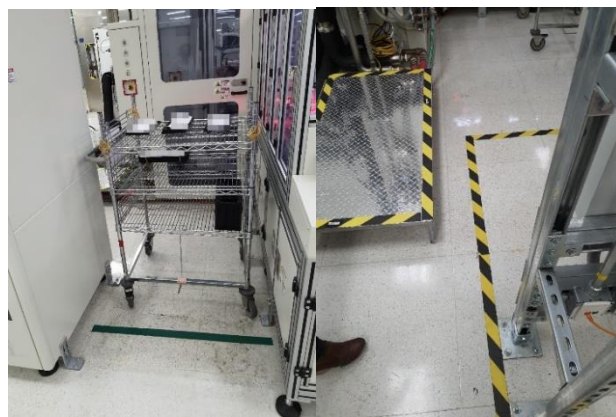
Figura 1. 2 Entradas hacia el tanque LTIM. Fuente: Elaboración propia
