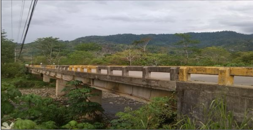
Figura 38. Puente Rio Uvita Vista general superestructura. Fuente: www.mopt.go.cr , aplicación SAEP. Inventario de puentes rutas nacionales
