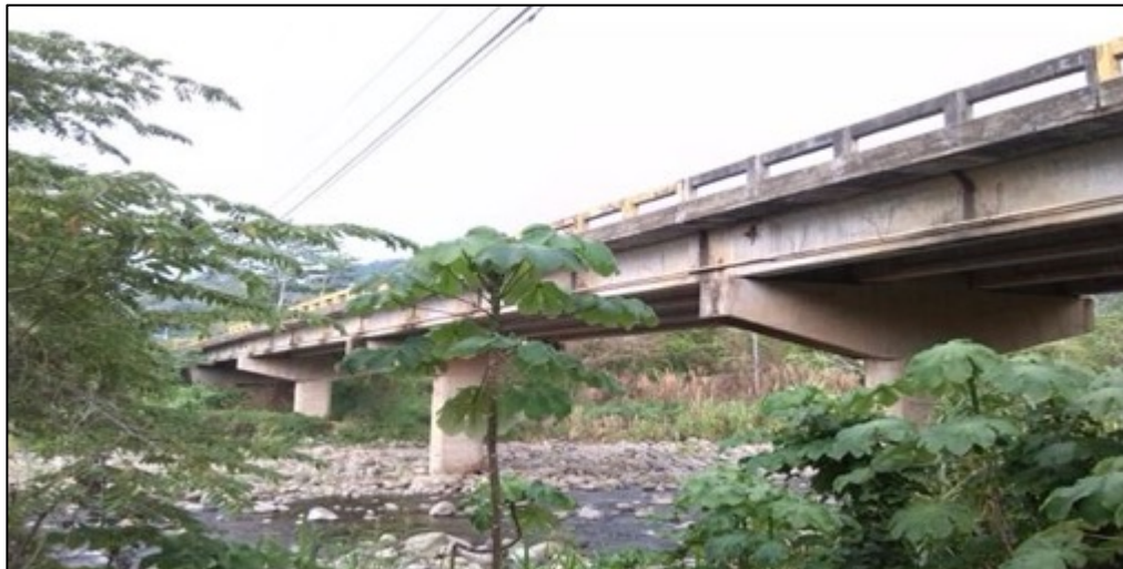
Figura 39. Puente Rio Uvita. Vista lateral superestructura. Fuente: www.mopt.go.cr , aplicación SAEP. Inventario de puentes rutas nacionales
