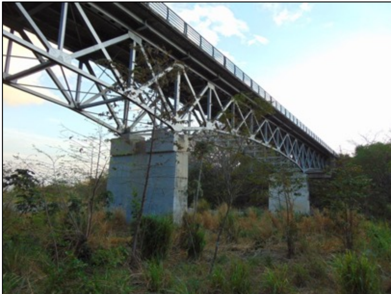
Figura 42. Puente Rio Aranjuez Vista lateral superestructura. Fuente: MOPT, programa de administración de puentes SAEP
