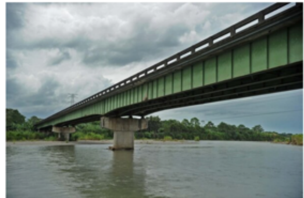
Figura 18. puente #17 superestructura tipo viga continua de acero sección variable sobre el rio Chirripó ruta fuente: https://www.nacion.com/el-pais/infraestructura/mopt-descarta-riesgo-en-puente-sobre-rio-chirripo-en-ruta-32/HDEMNQNI6JBRBO7KIIP4AAD4WE/story/ periódico La Nación 28 mayo 2015,
