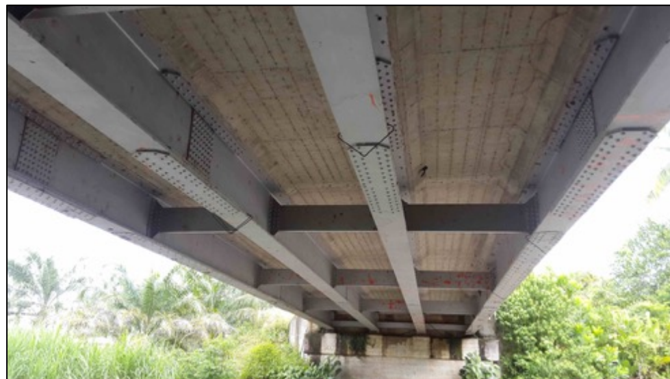
Figura 34. Puente Rio Olla Cinco Vista inferior superestructura. Fuente: MOPT, programa de administración de puentes SAEP
