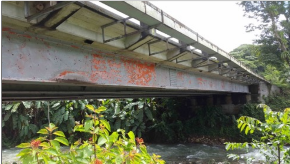
Figura 33. Puente Rio Olla Cinco Vista lateral. Fuente: MOPT, programa de administración de puentes SAEP
