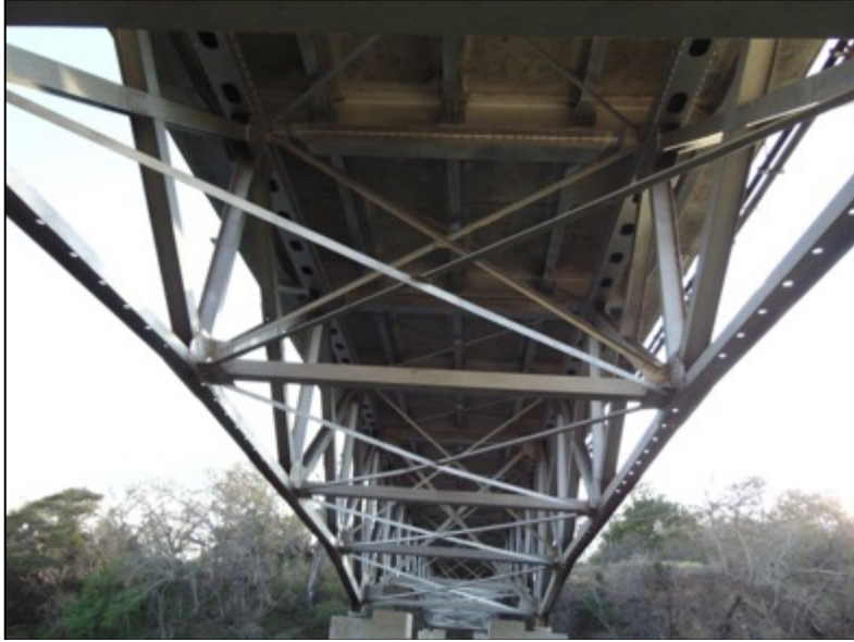
Figura 41. Puente Rio Aranjuez Vista inferior superestructura. Fuente: MOPT, programa de administración de puentes SAEP
