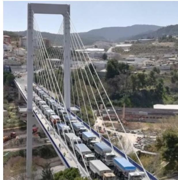
Figura 8. imagen prueba de carga con camiones sobre Rio Fernando Reig. en puente tipo atirantado. Fuente: Ministerio de Fomento de España.
