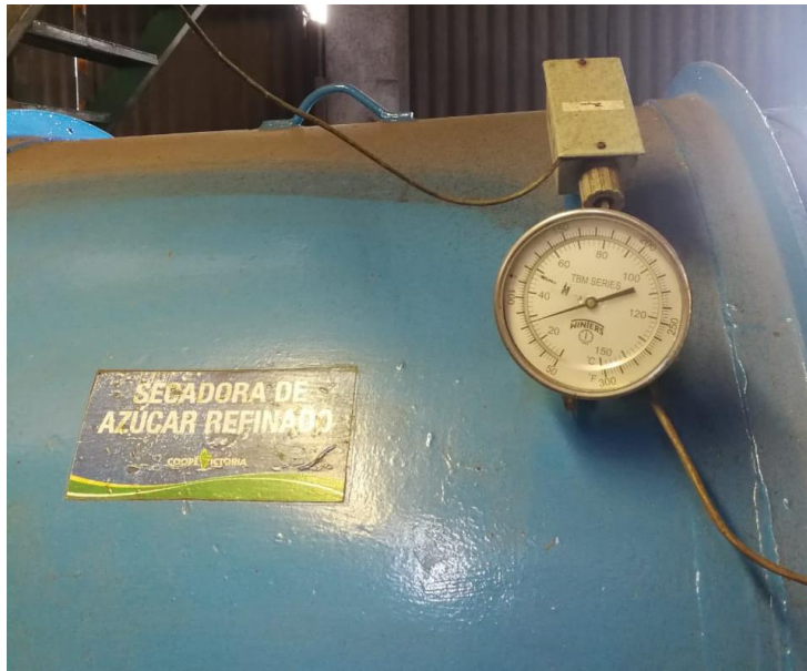
Figura 3-11. Sensor de temperatura. Fuente. Coopevictoria R.L.
