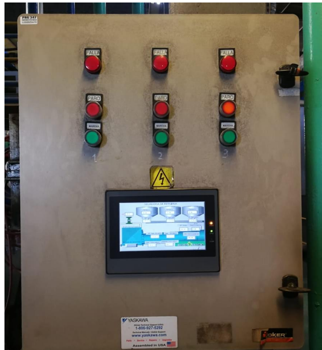
Figura 3-12. Panel de control y pantalla HMI. Fuente. Coopevictoria R.L.
