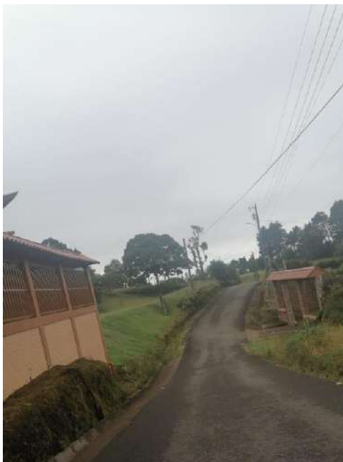
Figura 113. Drenajes en camino 3-08-015. Fuente: Elaboración propia utilizando la cámara del celular.
