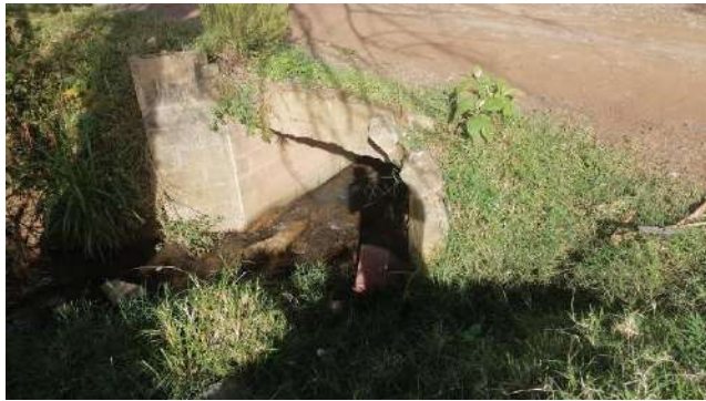
Figura 36. Drenajes en camino 3-08-111.
