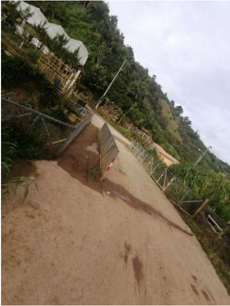
Figura 62. Puente en camino 3-08-196. Fuente: Elaboración propia utilizando la cámara del celular.
