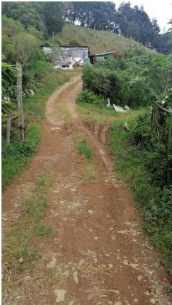
Figura 74. Drenajes en camino 3-08-229.
