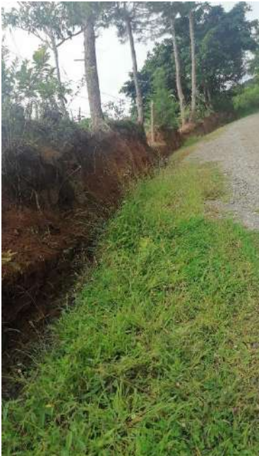
Figura 67. Drenajes en camino 3-08-197.
