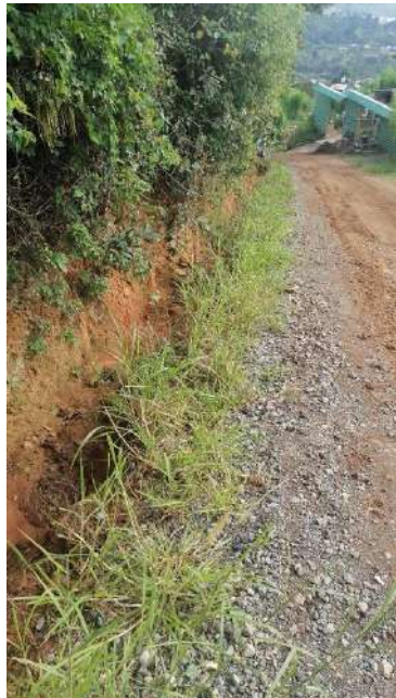
Figura 52. Drenajes en camino 3-08-190.
