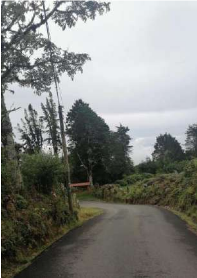
Figura 105. Parte en asfalto 3-08-013.
