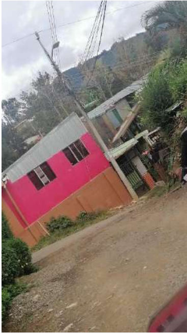
Figura 55. Inicio camino 3-08-191. Fuente: Elaboración propia utilizando la cámara del celular.
