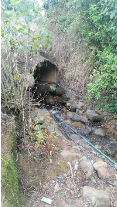
Figura 32. Drenajes en camino 3-08-089.
