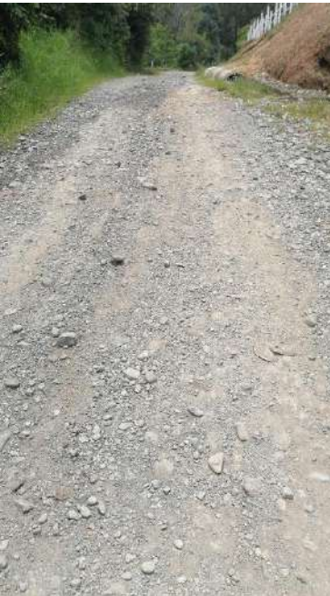
Figura 90. Drenajes en camino 3-08-234.
