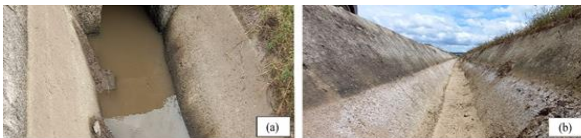
Figura 4.10. Secciones revestidas para medición de caudal de riego para Lote Piches (a) y Lote Inés (b)
