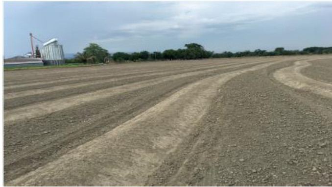
Figura 3.5. Construcción de taipas para arroz
