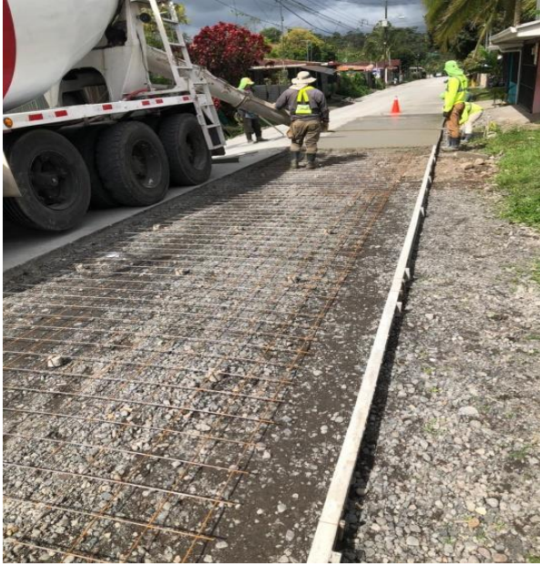
Colado de losa de concreto. Guápiles, Pococí.
