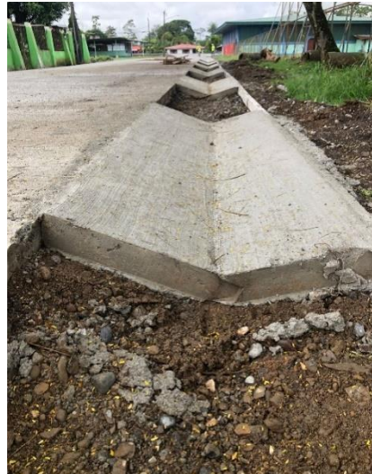
Figura 4. Construcción de cuneta y cordón de caño.
