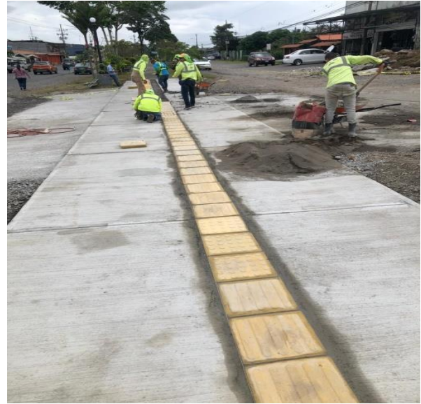
Acera con loseta táctil. Boulevard, Guápiles, Pococí.
