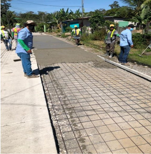
Colado del concreto (losa de concreto). Guápiles, Pococí.
