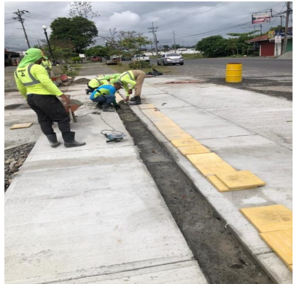
Colocación de loseta táctil. Boulevard, Guápiles, Pococí.
