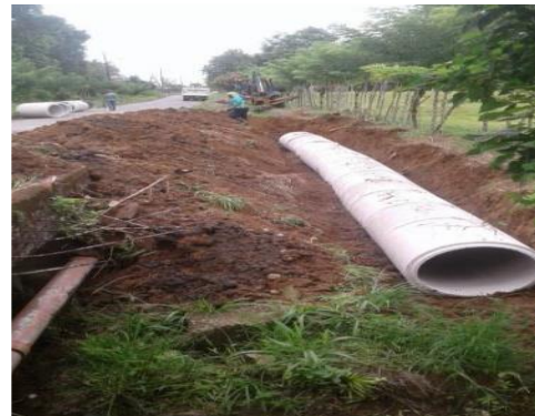
Figura 75. Colocación de alcantarillado. Fuente: Acta de cierre OCSM – 138– 2021.
