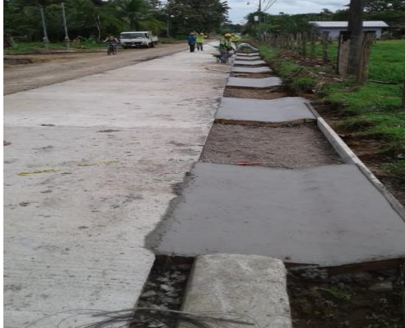
Figura 77. Colado de cunetas. Fuente: Acta de cierre OCSM – 138– 2021.
