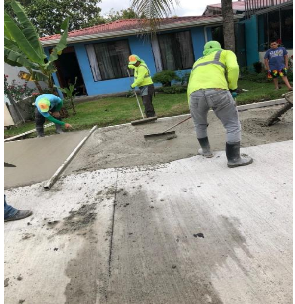
Acabados del concreto (losa de concreto). Guápiles, Pococí.
