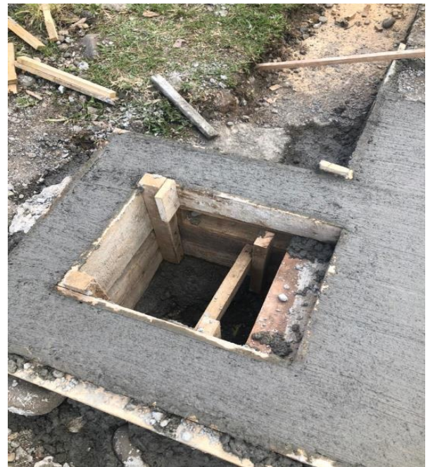
Colado de concreto (caja de registro) Boulevard, Guápiles, Pococí.
