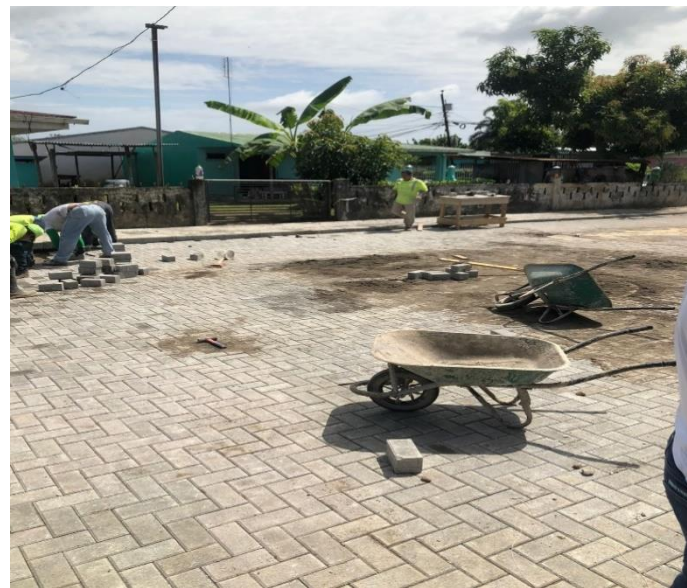
Figura 6. Construcción de pavimento de adoquines.
