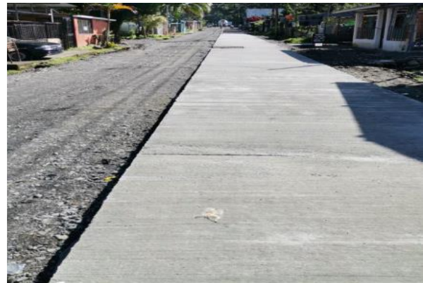
Figura 76. Losas de concreto armado (calle). Fuente: Acta de cierre OCSM – 138– 2021.
