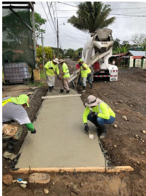
Figura 3. Construcción de aceras (sin losetas)
