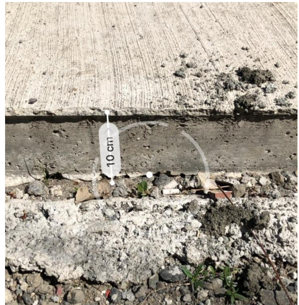
Espesor de losa de concreto. Guápiles, Pococí.
