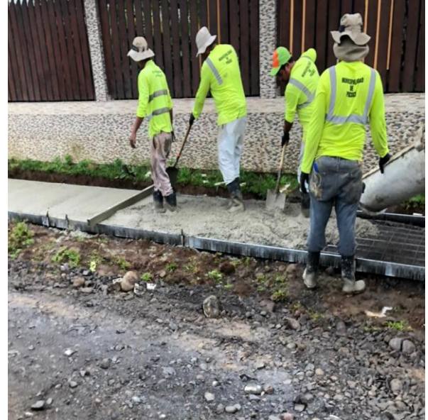
Colado del concreto (acera). Cariari, Pococí.
