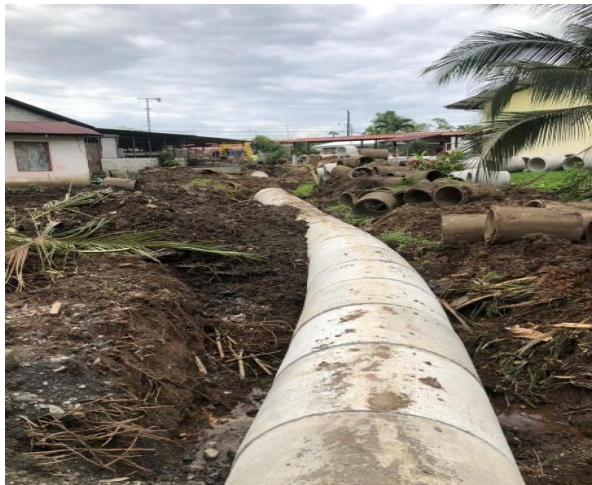
Figura 4. Colocación de alcantarillado. Fuente: Propia autoría.
