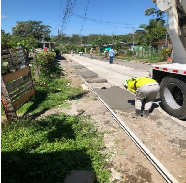
Construcción de cunetas. Los Bovinos, Toro Amarillo, Guápiles, Pococí.
