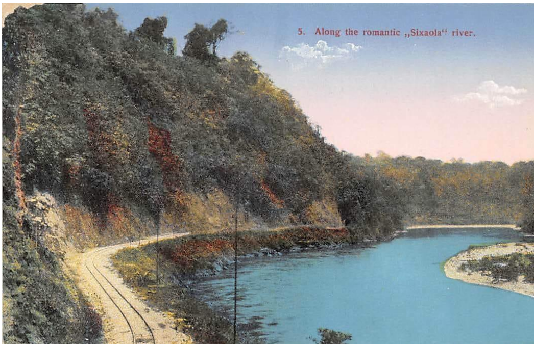
FIGURA NO. 35. FOTOGRAFIA DE LA ANTIGUA LINEA DEL FERROCARRIL Y TUNEL EN BAMBÚ UBICADO EN EL MARGEN DEL RÍO SIXAOLA, HOY CERCA DE LA COMUNIDAD DE BAMBÚ (BRATSI).
