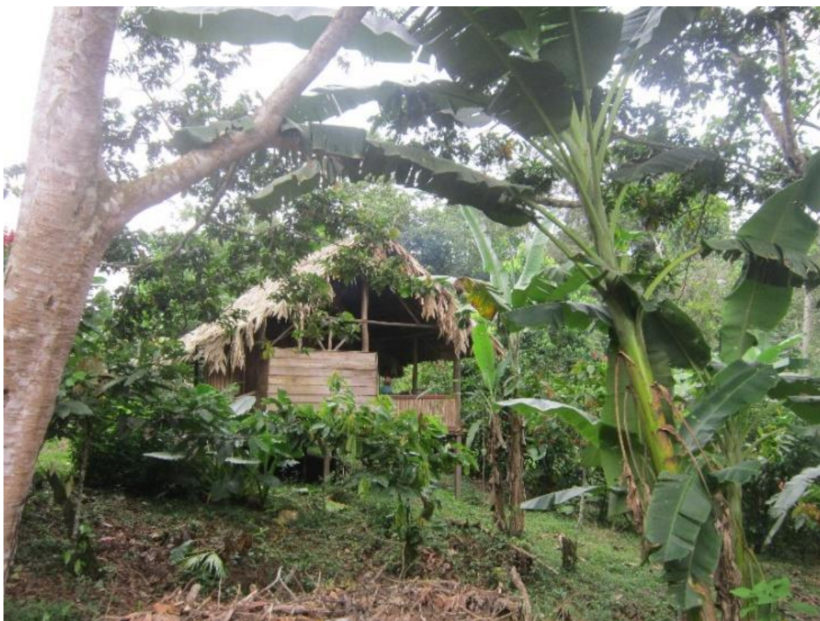
FIGURA No. 43. COCINA-COMEDOR PRINCIPAL DE STIBRAWPA CON TECHO DE HOJA DE SUITA RENOVADO.
