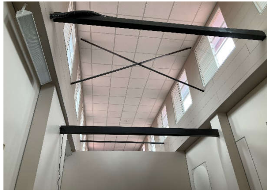
Figura 35. Detalle de estructura de techo.
