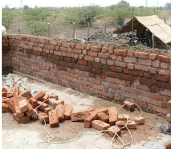
Figura 23. Muro de mampostería simple en construcción.
