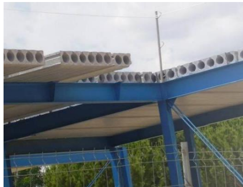
Figura 38. Entrepiso de losa multitubular.
