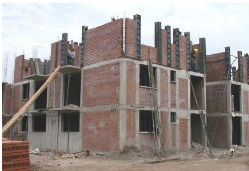
Figura 25. Muro de mampostería no reforzada confinada en construcción.
