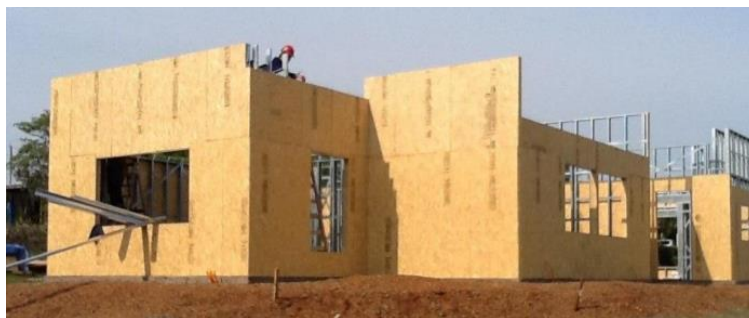
Figura 33. Construcción en acero laminado en frío.
