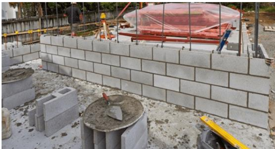
Figura 27. Muro de mampostería reforzada en construcción.
