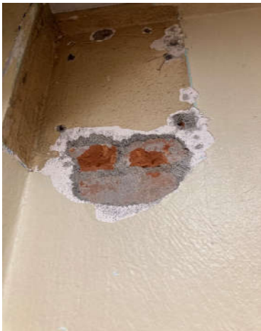
Figura 33. Detalle de pared de mampostería confinada.
