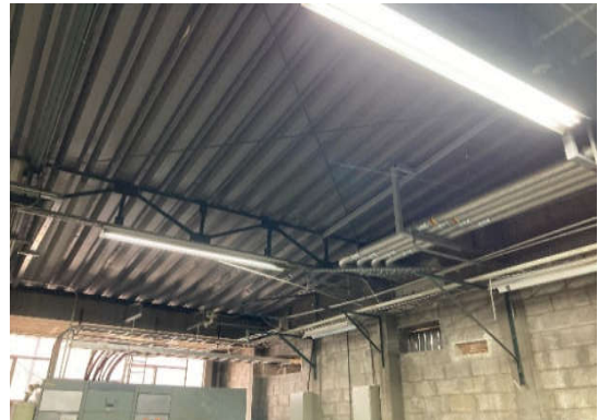
Figura 28. Detalle de estructura de techo.
