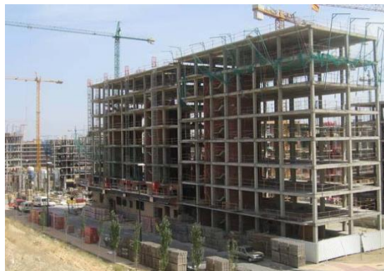
Figura 17. Sistema estructural de marcos de concreto reforzado.
