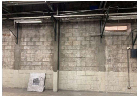
Figura 27. Detalle de pared de mampostería confinada.
