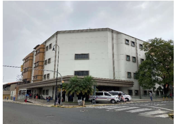
Figura 24. Fachada principal del edificio Torre Sur.
