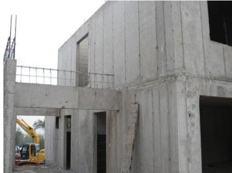
Figura 18. Sistema estructural de muros de concreto reforzado.
