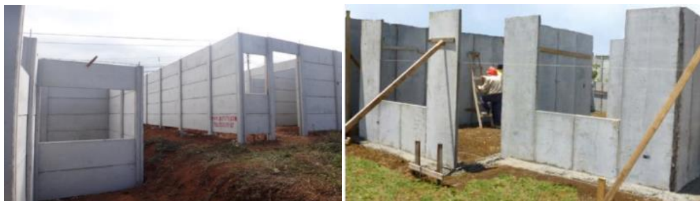
Figura 20. Estructuras de concreto prefabricado.
