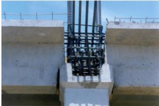
Figura 21. Nudo viga-columna a ser colada en sitio.
