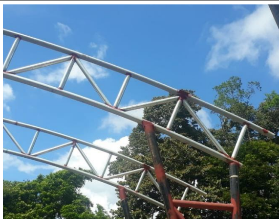
Foto 1. Aplicación de pintura anticorrosiva en estructura de techo Visita 2
