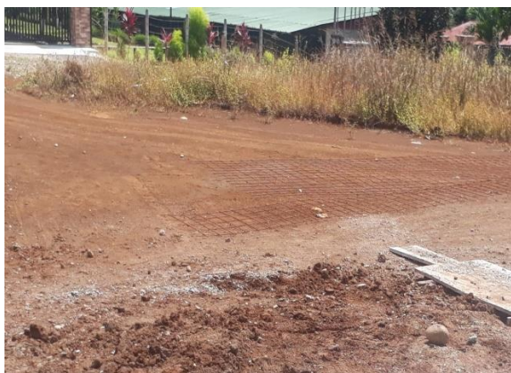
Foto 5. Dimensiones adecuadas de registro de tanque séptico. Visita 4
