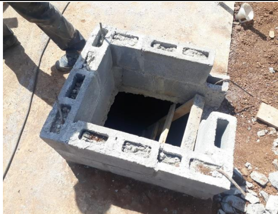
Foto 5. Dimensiones adecuadas de registro de tanque séptico. Visita 2
