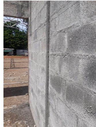
Foto 2. Uso de mampostería clase A. Visita 1
