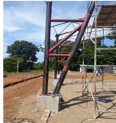
Figura 3. Columnas metálicas. Fuente: Propia.
