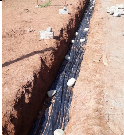
Foto 6. Dimensiones de zanja de drenaje conforme a los planos constructivos. Visita 2
