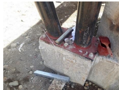
Figura 4. Pedestales de concreto reforzado. Fuente: Propia.
