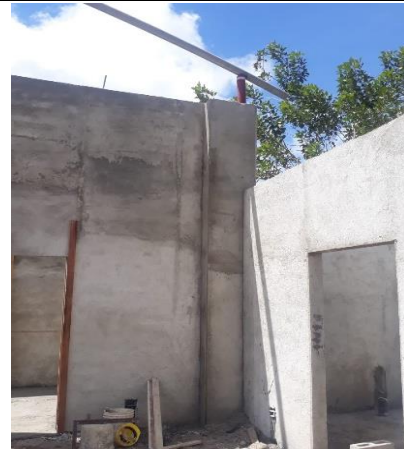
Foto 2. Reparación de hormigueros en columna. Visita 2
