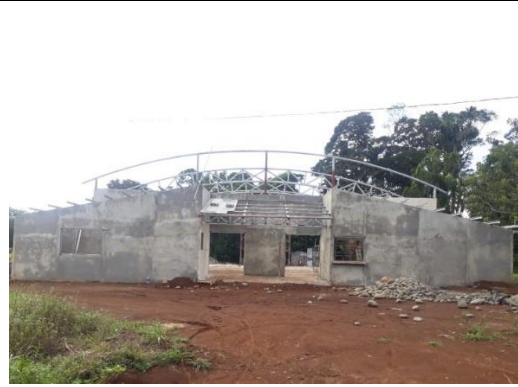
Foto 2. Estructura de techo sobre entrada principal. Visita 3
