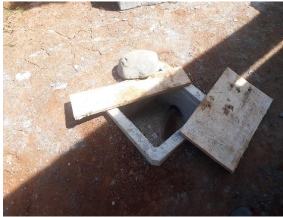
Foto 3. Material y dimensiones de caja de registro adecuados. Visita 2
