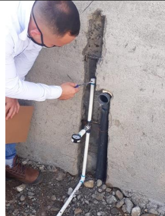
Foto 4. Medición de presión en tuberías de agua potable. Visita 2
