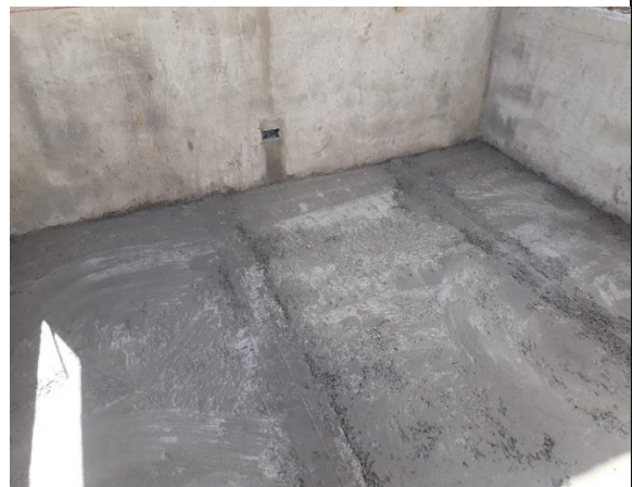
Foto 6. Dimensiones de zanja de drenaje conforme a los planos constructivos. Visita 4
