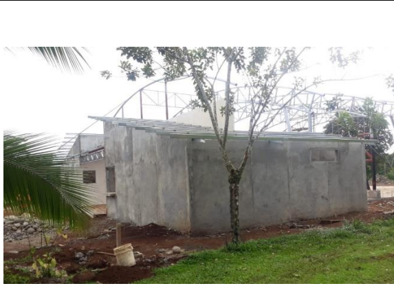
Foto 1. Estructura de techo sobre baños. Visita 3
