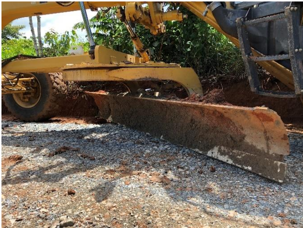
Figura 31. Hoja de la niveladora Municipal. Fuente: fotografía capturada por el autor.
