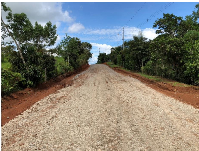
Figura 43. Reconfiguración de camino municipal con lastre. Fuente: fotografía capturada por el autor.
