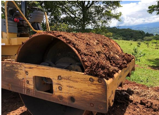
Figura 62. Condiciones externas repercuten trabajabilidad en los proyectos.
