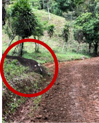
Figura 58. Presencia de rocas enterradas que la niveladora no pudo mover.
