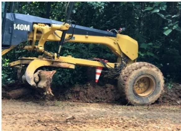
Figura 59. Niveladora realizando salida de agua con cuchilla.
