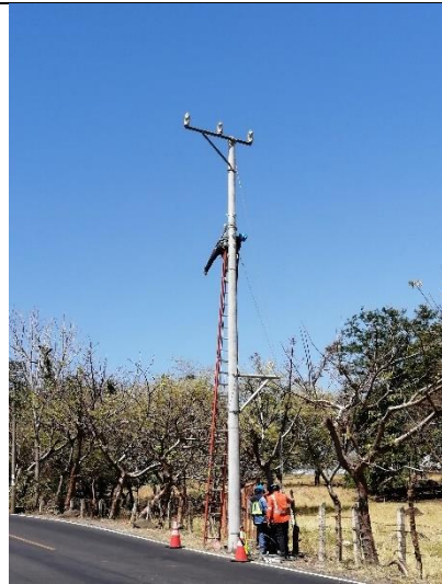
Figura 16. Anclaje de poste.
