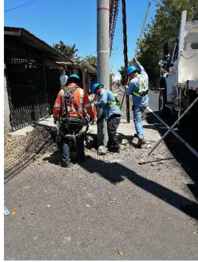
Figura 14. Sembrado de poste.
