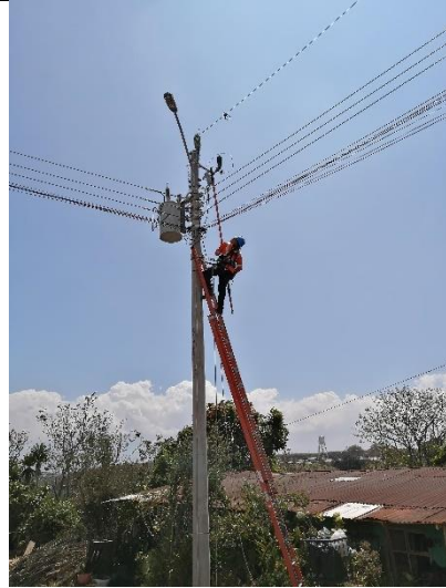
Figura 20. Trabajo con ayuda de pértiga para brindar la energía.
