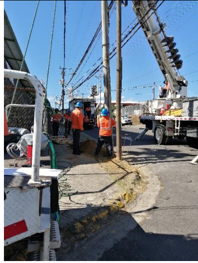
Figura 6. Siembra de nuevo poste.
