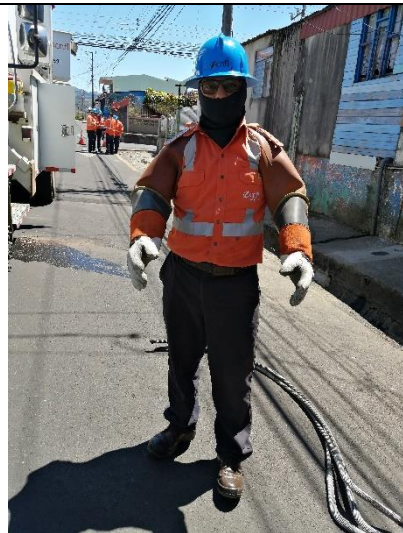
Figura4. Equipo de protección personal completo de líneas energizadas.
