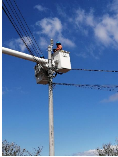
Figura 18. Trabajo de colocar aisladores pararrayos en poste con ayuda de grúa.
