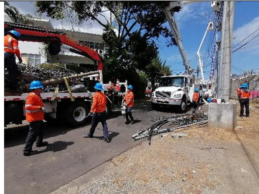
Figura 24. Recolección de material retirado para colocarlo sobre la grúa.
