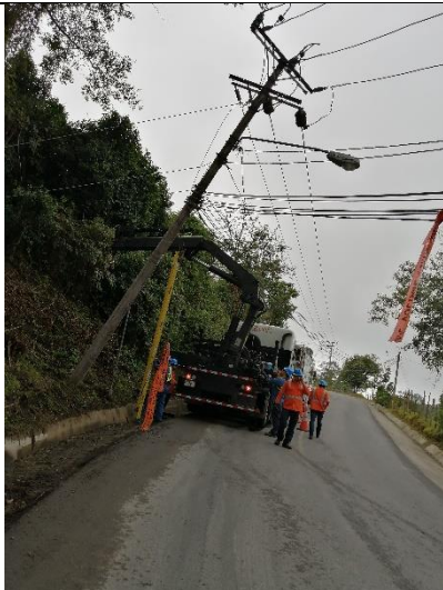
Figura 27. Grúa levantando de nuevo el poste para sostener las líneas.
