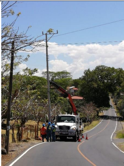
Figura 11. Izado de poste de concreto.
