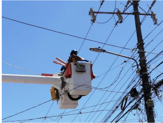
Figura1. Personal en grúa cubriendo las líneas con energía.
