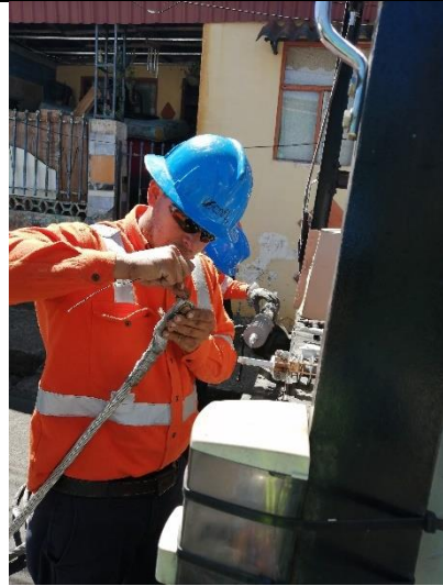
Figura2. Personal en piso preparando el material que va ser remplazado.
