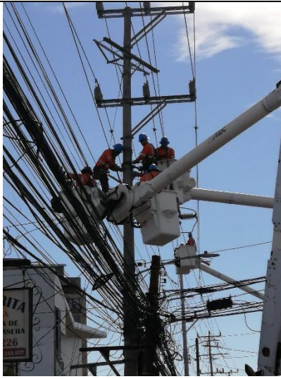
Figura 21. Colocación de tierras y retiro de material con ayuda de grúa.
