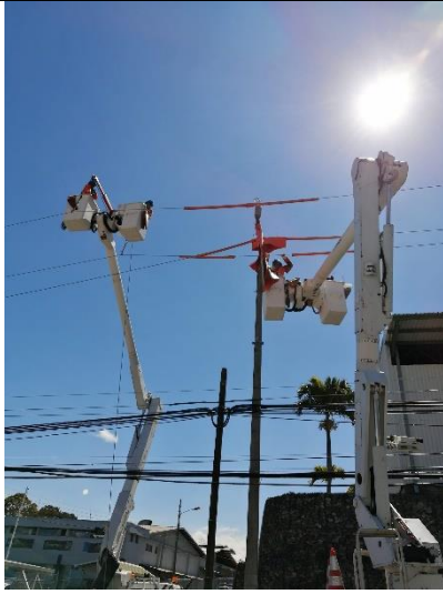
Figura 5. Trabajo en líneas energizadas.
