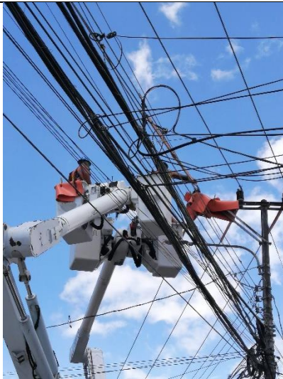
Figura 7. Cambio de aisladores sobre líneas energizadas.
