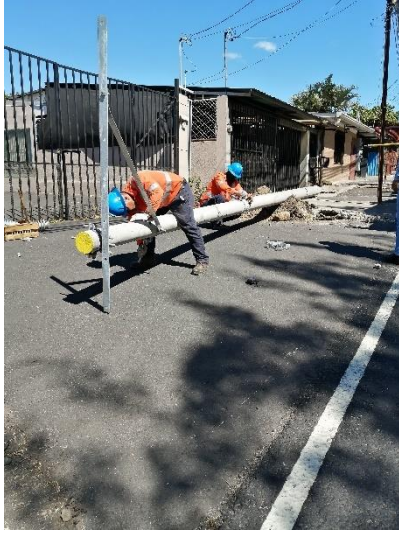
Figura 13. Preparación del poste previo a ser izado.
