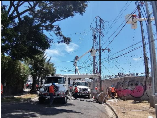
Figura 23. Trabajo en equipo de grúas con personal en escalera.
