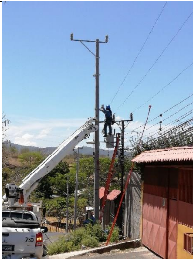
Figura 15. Trabajo de líneas en frío sobre el nuevo poste.
