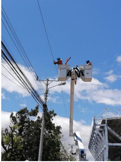
Figura 31. Personal colocando dispositivos para cubrir las líneas.
