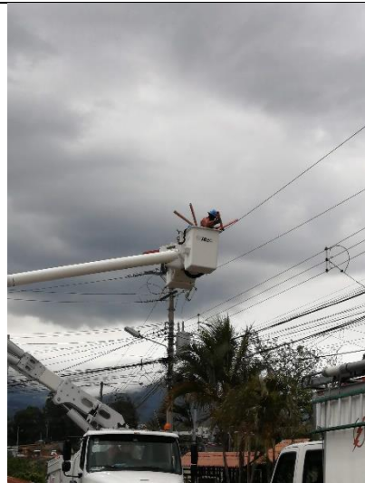
Figura 34. Personal de líneas energizadas vistiendo la línea eléctrica.
