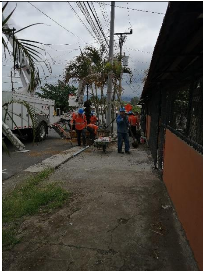
Figura 33. Trabajo de mezcla de cemento con piedra para nuevo sitio de ancla.
