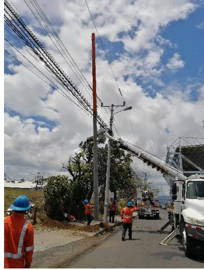
Figura 32. Izado de poste con energía de por medio.
