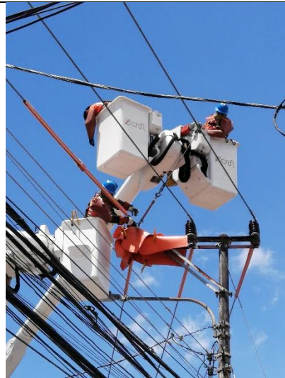
Figura 8. Grúa superior sostiene la línea mientras se realiza el cambio por la grúa inferior.
