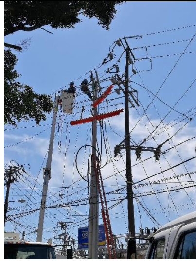
Figura 22. Trabajo de retiro de materiales viejos.
