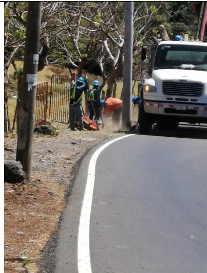
Figura 12. Preparación de mezcla de concreto para el ancla del poste.
