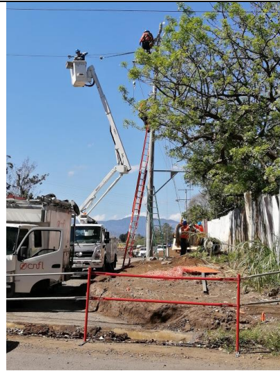
Figura 36. Proceso de tensado y tiraje de líneas eléctricas.
