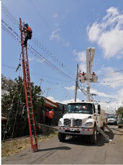
Figura 19. Trabajo sobre escalera de conexión de nuevos servicios.
