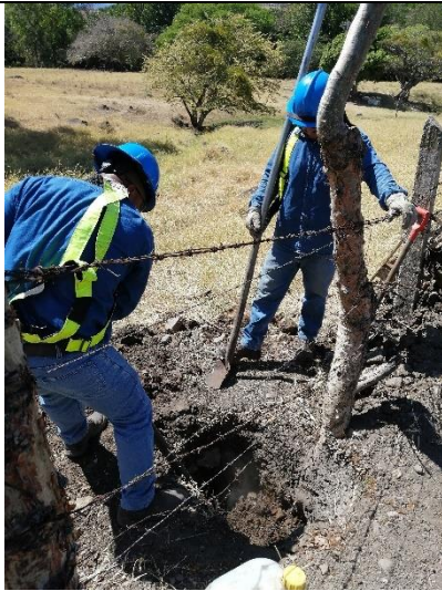
Figura 9. Trabajo manual para realizar hueco para ancla de poste.
