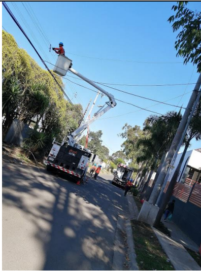
Figura 35. Personal laborando sobre grúa en proceso de conexión de servicios.
