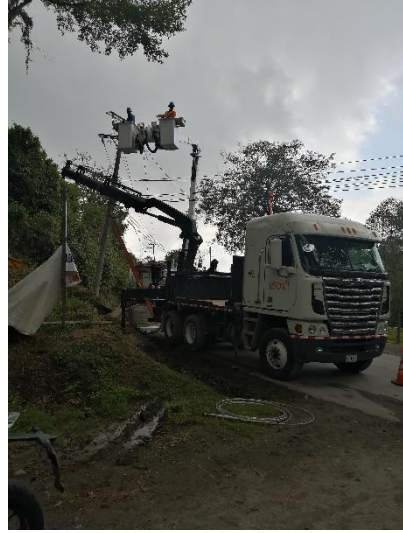
Figura 30. Retiro de líneas viejas con ayuda de grúa de canasta.
