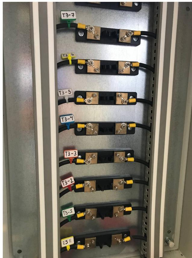
Figura 4.13: Instalación de las resistencias shunt. Fuente: Elaboración propia
