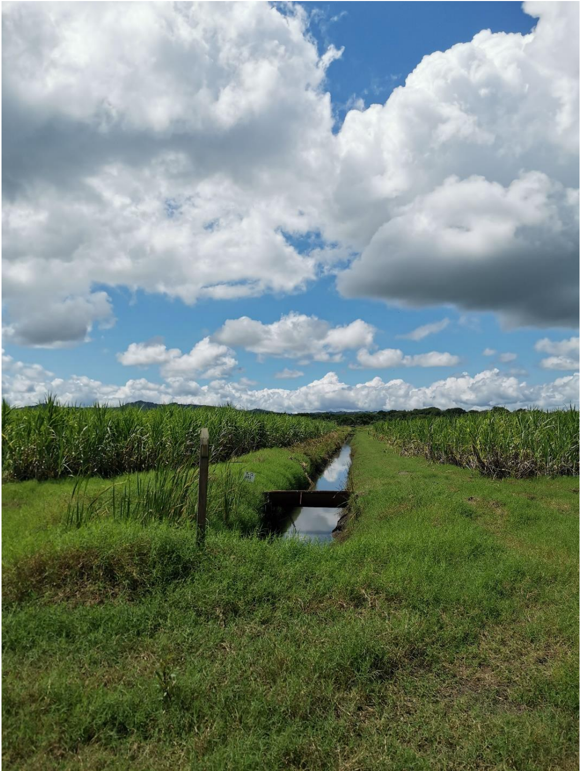
Figura 42. Estado de los drenes en sector Salimas luego de construcción de tapones y limpieza en los drenes de desagüe.
