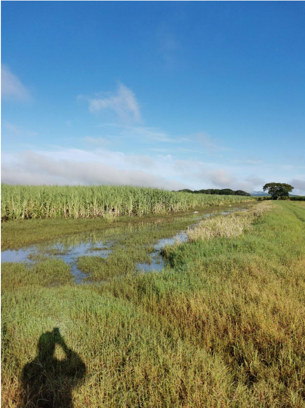
Figura 40. Estado de los drenes en Sector Salimas antes de la construcción de tapones y limpieza en los drenes de desagüe.
