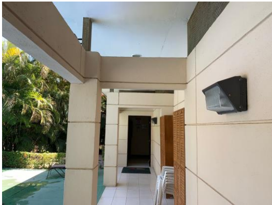
Figura 33. Exterior de los baños y vestidores. Fuente: Elaboración propia.
