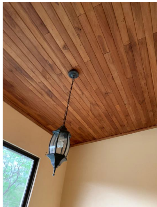
Figura 17. Cielo de madera de las villas tipo 1000. Fuente: Elaboración propia.
