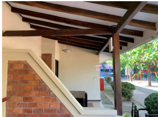
Figura 12. Estructura de madera de las villas tipo 604-605. Fuente: Elaboración propia.
