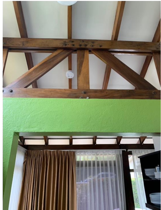
Figura 19. Estructura de madera que sostiene el peso de la teja.
