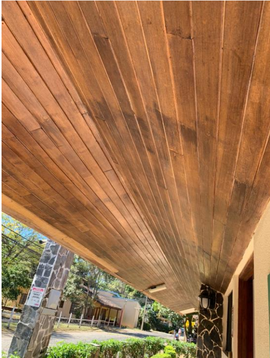
Figura 8. Cielo externo de madera de las villas 307-311. Fuente: Elaboración propia.
