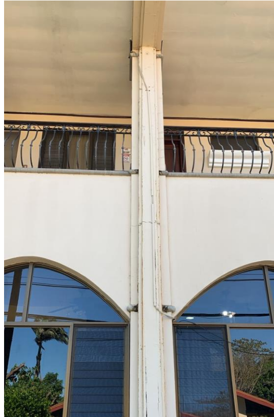
Figura 27. Cubierta de madera deteriorada colocadas en tubos bajantes de canoas. Fuente: Elaboración propia.
