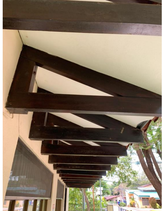
Figura 18. Estructura de madera que protege la entrada a la villa.
