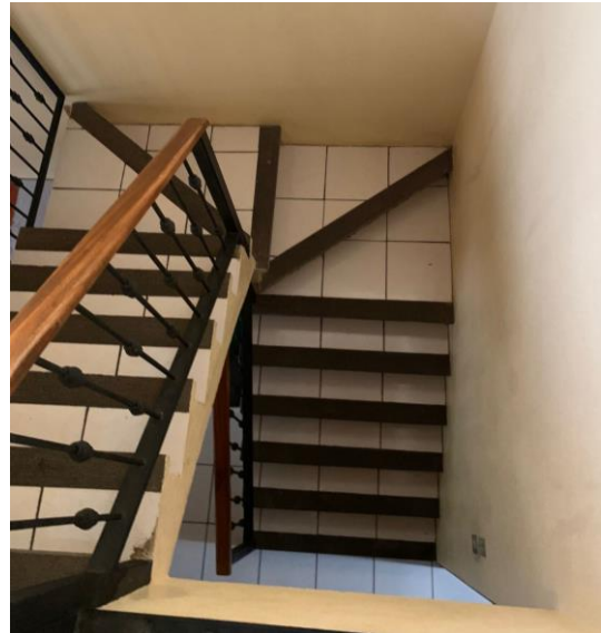
Figura 16. Escaleras de concreto de villas tipo 1000. Fuente: Elaboración propia.
