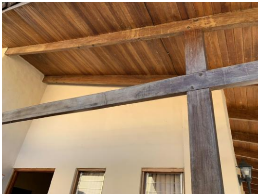
Figura 10. Estructura de madera de las villas tipo 103-110. Fuente: Elaboración propia.
