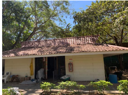
Figura 34. Casa de almacenamiento. Fuente: Elaboración propia.
