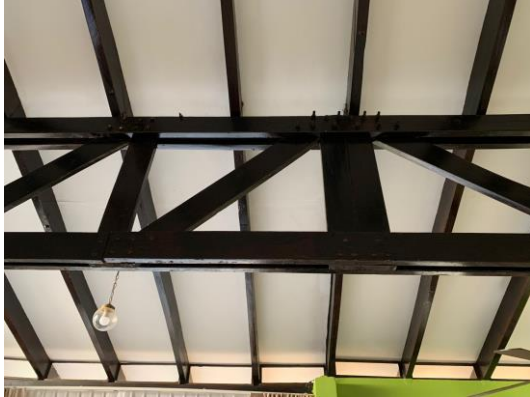
Figura 15. Cercha estructural de las villas 509 al 514. Fuente: Elaboración propia.
