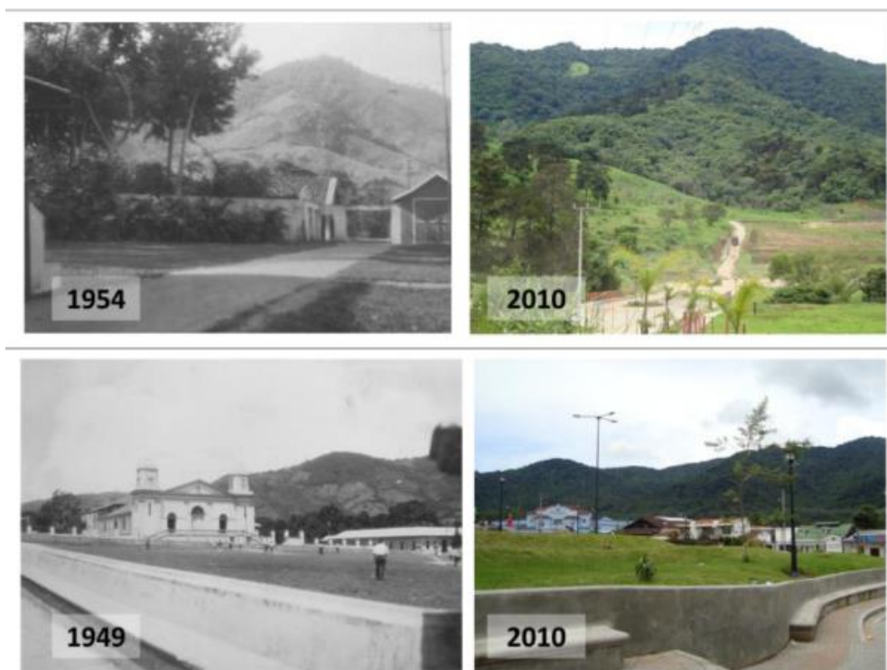
Figura 8 – Recopilación de Fotos de la ZPLC en su Frente Norte Comparando la Cobertura del Suelo entre la Mitad del Siglo XX y el Inicio de la Presente Década. Fuente: Conejo (2010).
