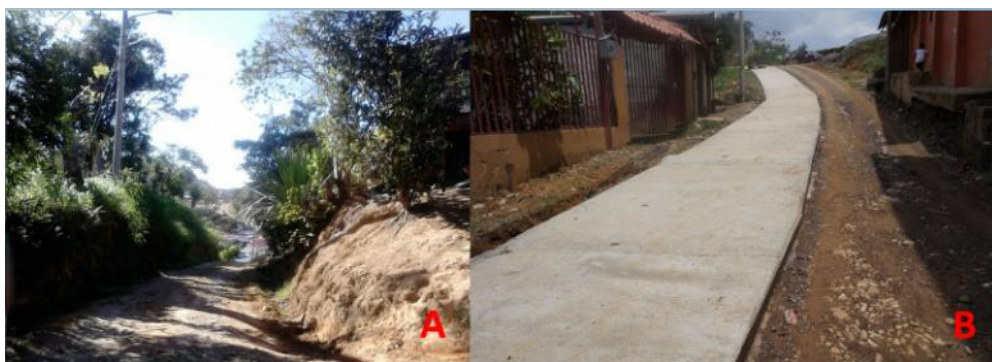
Figura 15 Condición de las Calles en Barrio Los Ángeles de Patarrá. Fuente: Modificado de Partido Unidad Social Cristiana Desamparados (2015).
