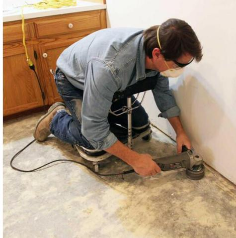
**Figura 9.** *Alternativa 3 para tarea barrenado y pijado utilización de plataforma para arrodillarse*
