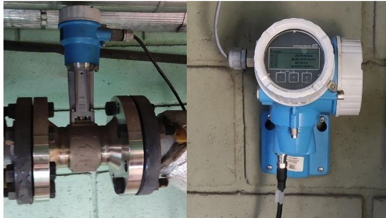
Figura 4.2.6. Medidor de flujo de vapor Endress+Hauser Proline Prowirl F 200 Hart. Variante de dispositivo de medición remota. Fuente: elaboración propia.
