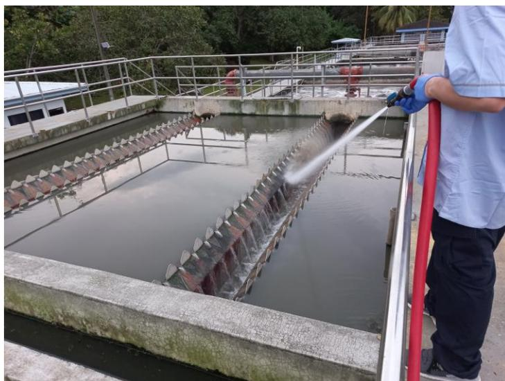
**Figura 1.11. 3. Lavado de vertederos en los sedimentadores primarios.**
