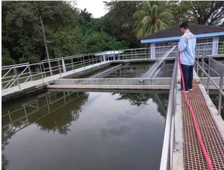
**Figura 1.11. 1. Lavado de vertederos en los sedimentadores secundarios.**
