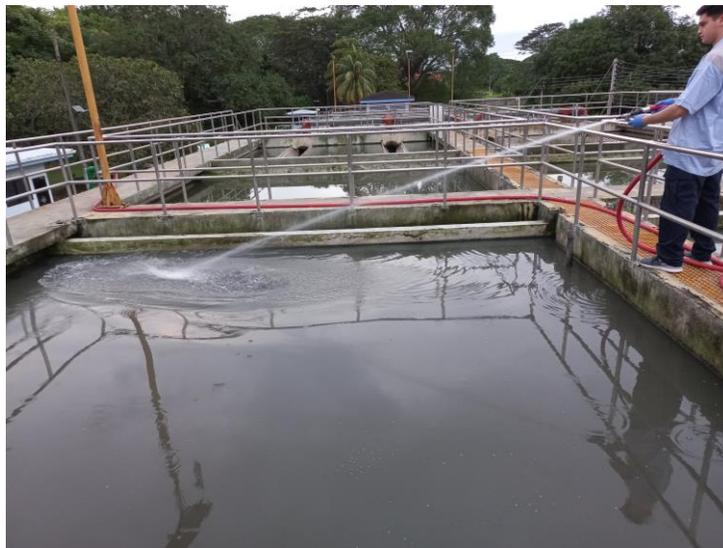
**Figura 1.11. 2. Lavado de sólidos flotantes en sedimentadores primarios.**
