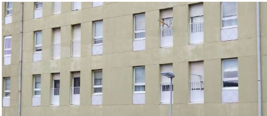
Figura 4.7: Imagen del edificio capturado con cámara de teléfono móvil.
