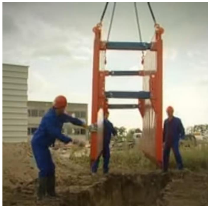
Figura 7: Blindaje para trincheras. Extraído de ricoinode (2009).
