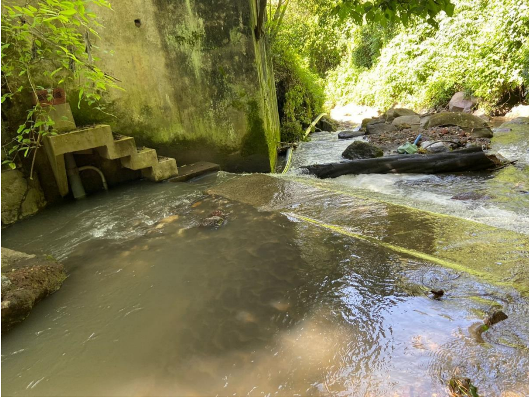
Anexo 32. Captación de agua en el Río Reventado
