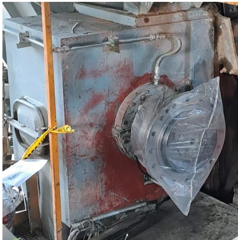
Figura 11. Encerramiento metálico actual del piñón-corona
