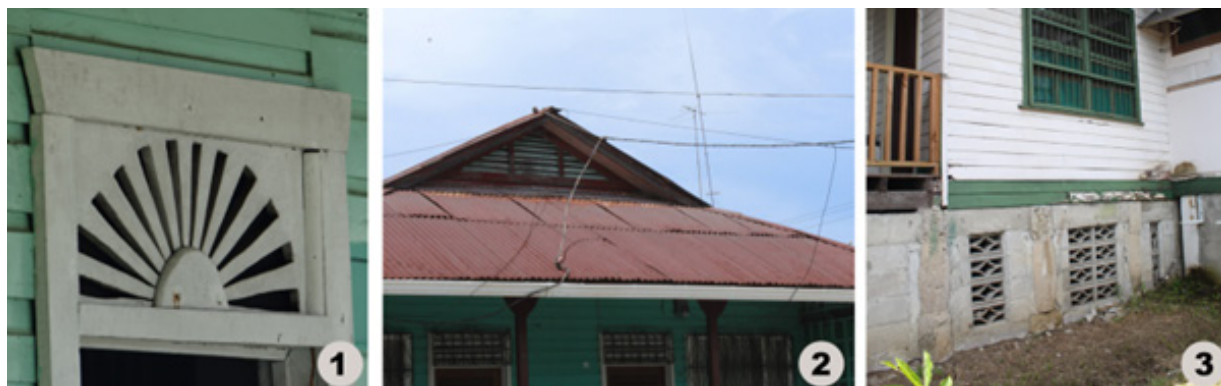
Figura 21. Elementos de ventilación en la arquitectura caribeña. 1. Ejemplo de abertura en pared. 2. Ejemplo de ventila de cámara plena (cielo ventilado). 3. Ejemplo de ventila de entrepiso. Fuente: propia.
