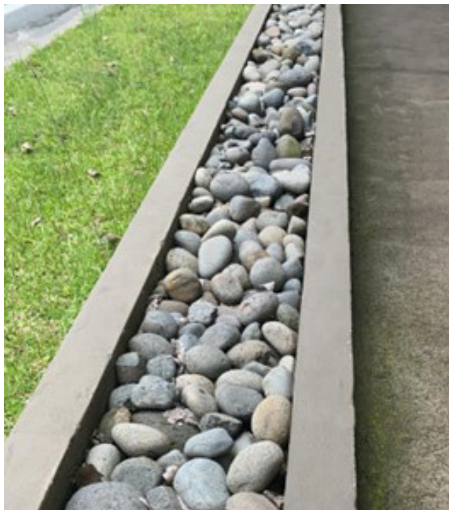
Figura 24. Caño o canal de suelo para recolección de lluvia. Fuente: propia
