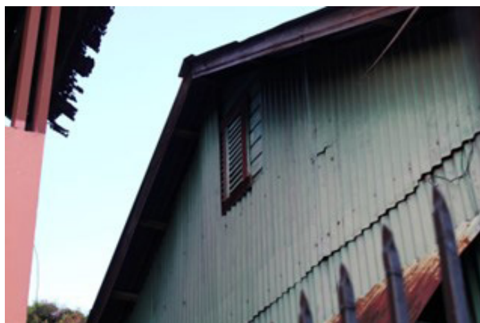
Figura 27. Uso de láminas metálicas como revestimiento exterior. Fuente: propia.
