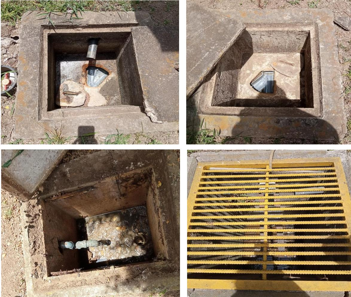
**Figura6.15: Tuberías que conducen de los inodoros al tanque.**
